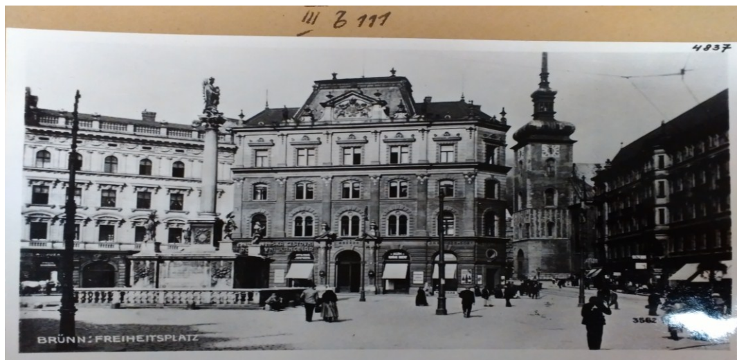
Obr. 31: Novostavba na místě bývalých paláců Žerotína a Lichtensteina. (AMB, Fond U 5, IIIb, inv. č. 111)
