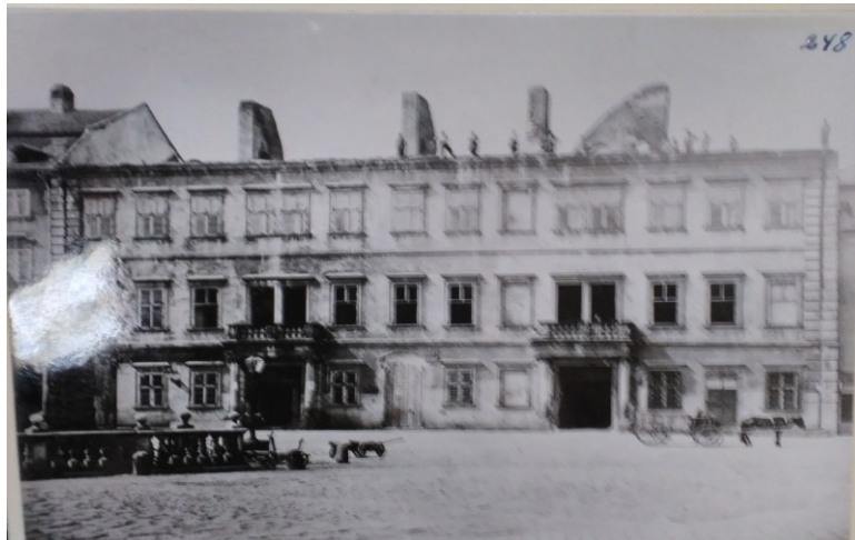
Obr. 46: Kounicův palác po požáru v roce 1868. (AMB, Fond U 7, L 116, inv. č. 248)
