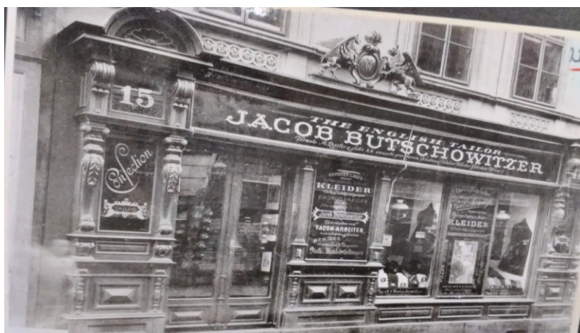
Příloha č 56 Výkladní skříň obchodu J. Butschowitzera v přízemí Kleinova domu č. p. 15.
