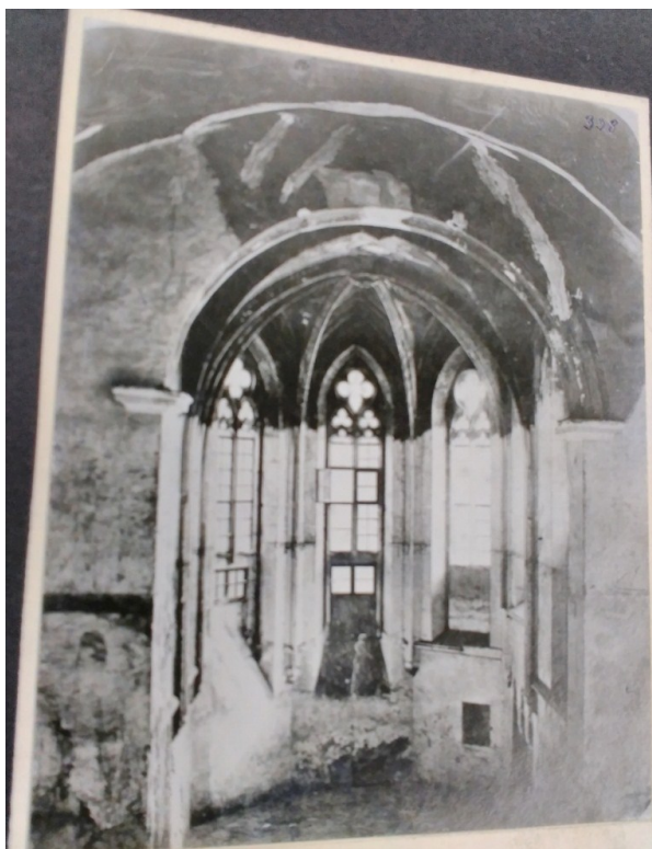
Příloha č 58 Presbytář kostela sv. Mikuláše před demolicí. Fotografie Q. Trapp, 1869.
