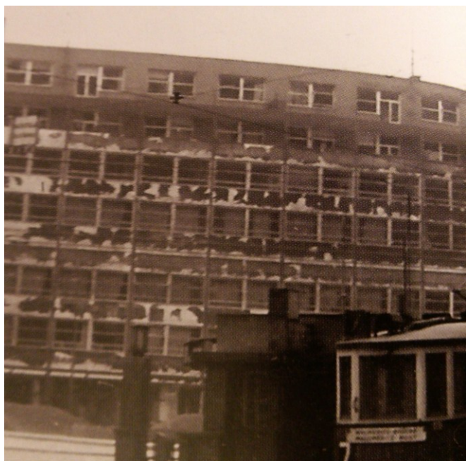
Příloha č 81 Zničená skleněná fasáda Moravské banky po spojeneckých náletech. Fotografie, rok 1944. Také je vidět poškození stavby brněnského hřibku a tramvajového vozu na náměstí Svobody. (Filip, 2013)
