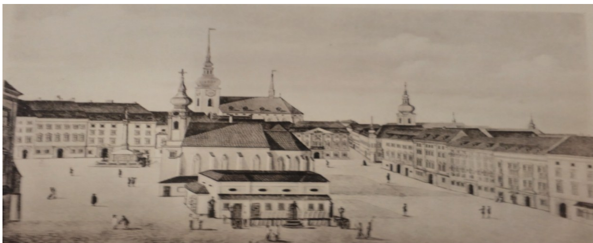
Obr. 2: Kresba pohlednice náměstí s dobovou kresbou z roku 1780. Pohled je na severovýchodní část náměstí směrem od jihu. Autor Leopold Misura. (AMB, Fond U 25, XVIIIa, inv. č. 4050)
