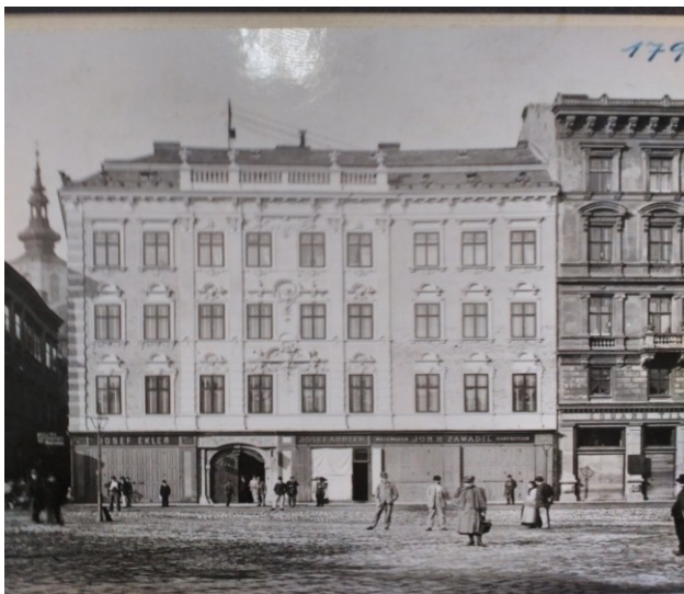
Obr. 42: Detail starého nájemního domu č. p. 26 před asanací. (AMB, Fond U 22, L 111, inv. č. 1791)
