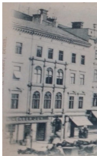
Obr. 67: Herringův dům na Velkém náměstí. (AMB, Fond U 7, L 116, XVIIIc22, inv. č. 601)
