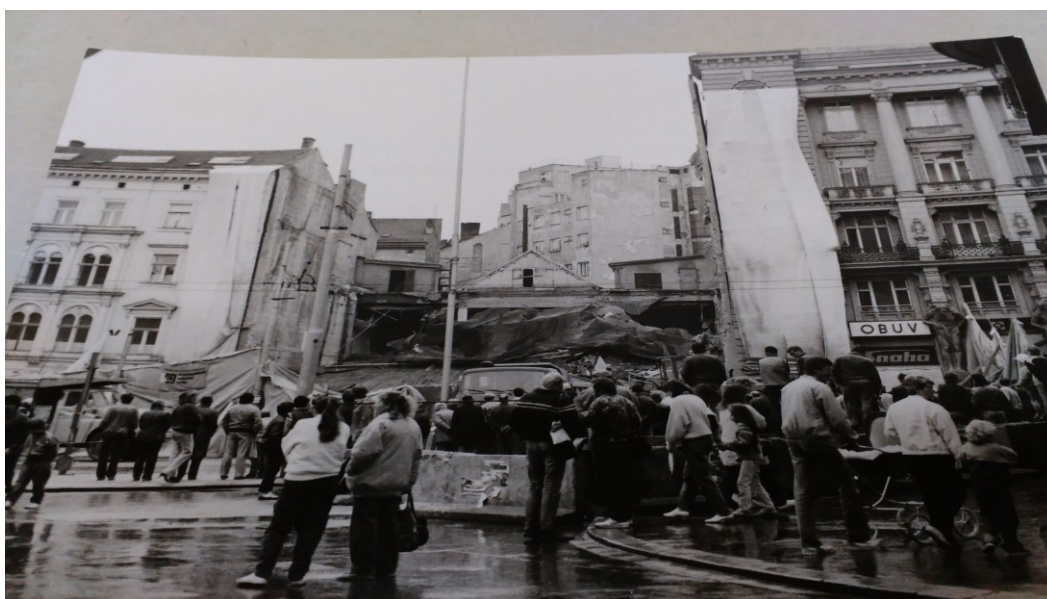
Příloha č 83 Stržení budovy obchodního domu JEP A. Fotografie, 1988. Snímek je zde doplněn pro celistvost náhledu na popisovanou východní stranu náměstí Svobody a také za účelem retrospektivy důsledků dějinných událostí v této brněnské lokalitě. (AMB, Fond U 5, III b, inv. č. 162 a inv. č. 163)
