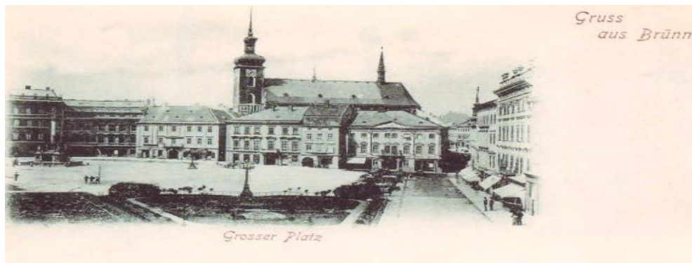
Obr. 17: Pohlednice s fotografií Velkého náměstí po roce 1870 a před rokem 1895. Úhel pohledu je od jihu, z dnešní Masarykovy ulice. (Marco, 1995)
