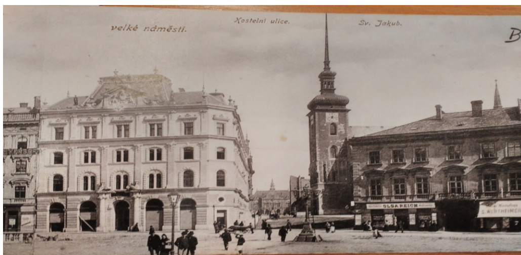
Obr. 28: Fotografická pohlednice ve stejném směru pohledu.
