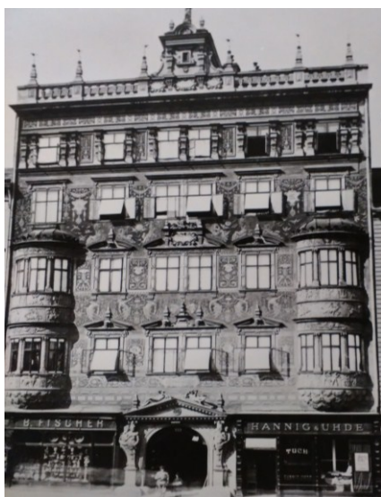
Obr. 58: Fasáda Schwanzova domu. 263
