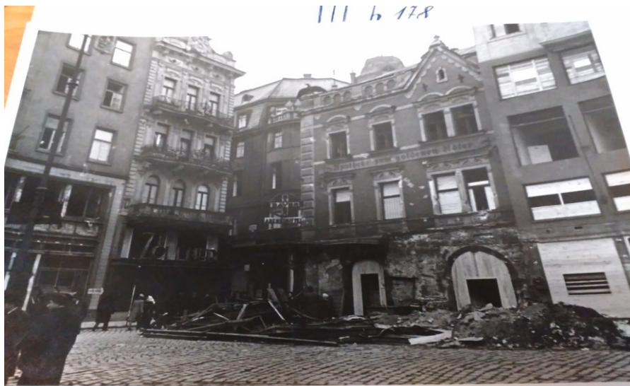
Obr. 38: Silně poničený dům U zlatého orla č. p. 1 po náletech v roce 1944-1945.
