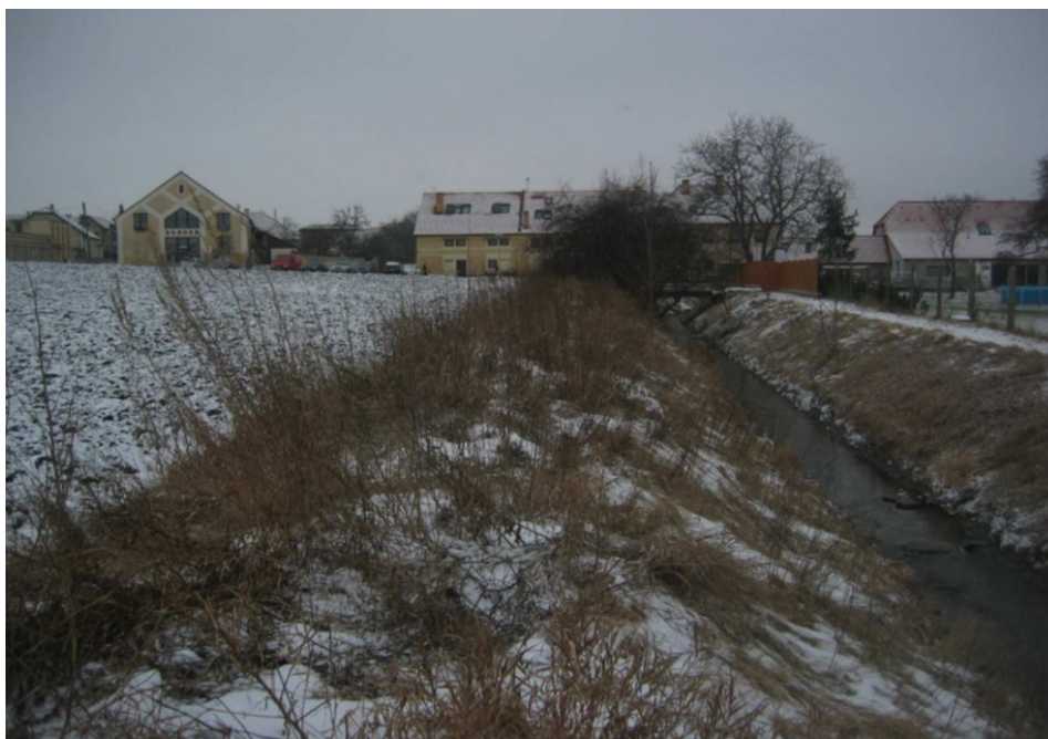
Obrázek 11: Zarůstající původně vybetonované koryto (zdroj: Viták 2010).
