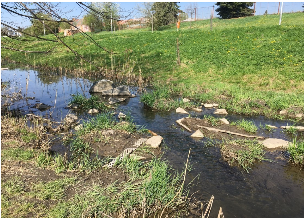
Příloha 11: Vložení kamenů do toku a zpevnění břehů zatravněním v horním úseku UČS 03 (zdroj: archiv autora).
