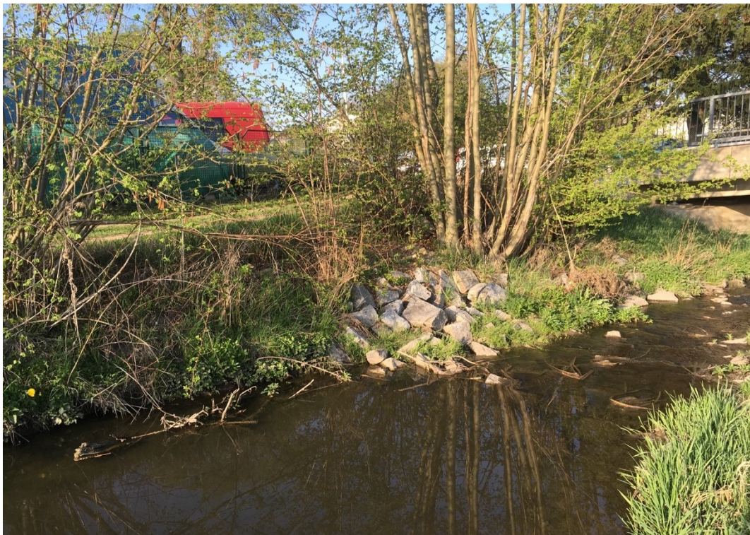
Příloha 13: Opevnění břehů koryta kamenným pohozem (zdroj: archiv autora).
