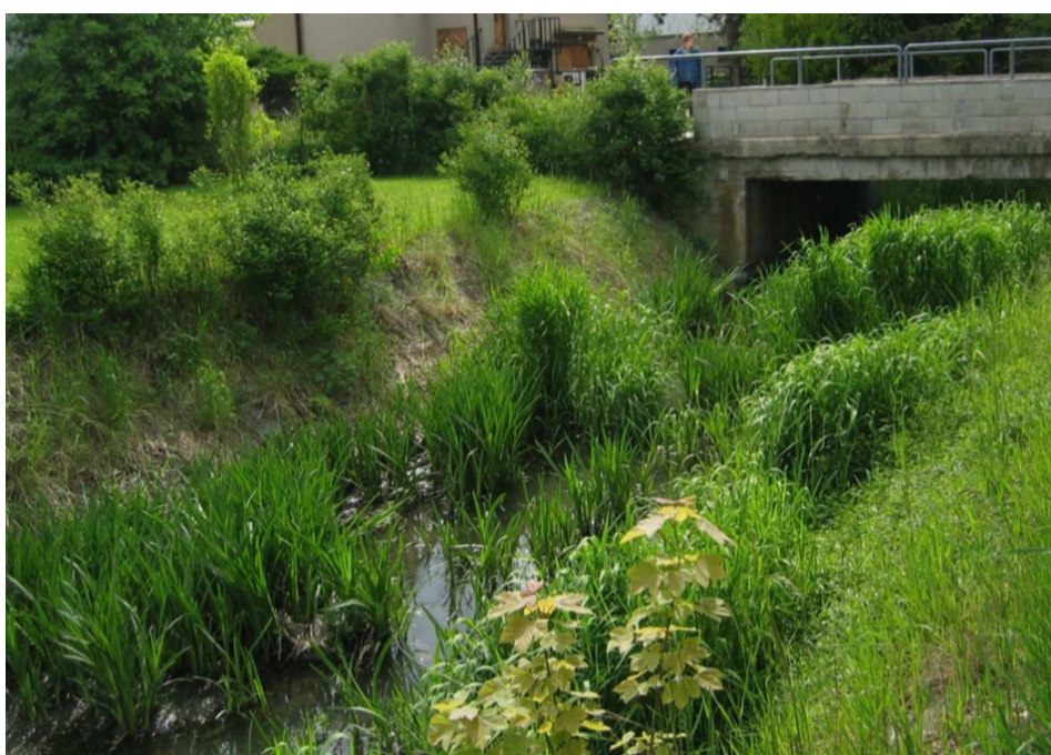
Obrázek 11: Zarůstající původně vybetonované koryto (zdroj: Viták 2010).
