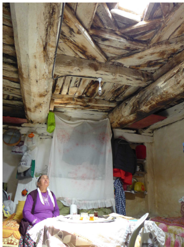
Obr. 9: Dům ve vesnici Ortaköy, který měl dříve sloužit jako cem evi (Sivas). Foto © K. Vytejšková 2013.
