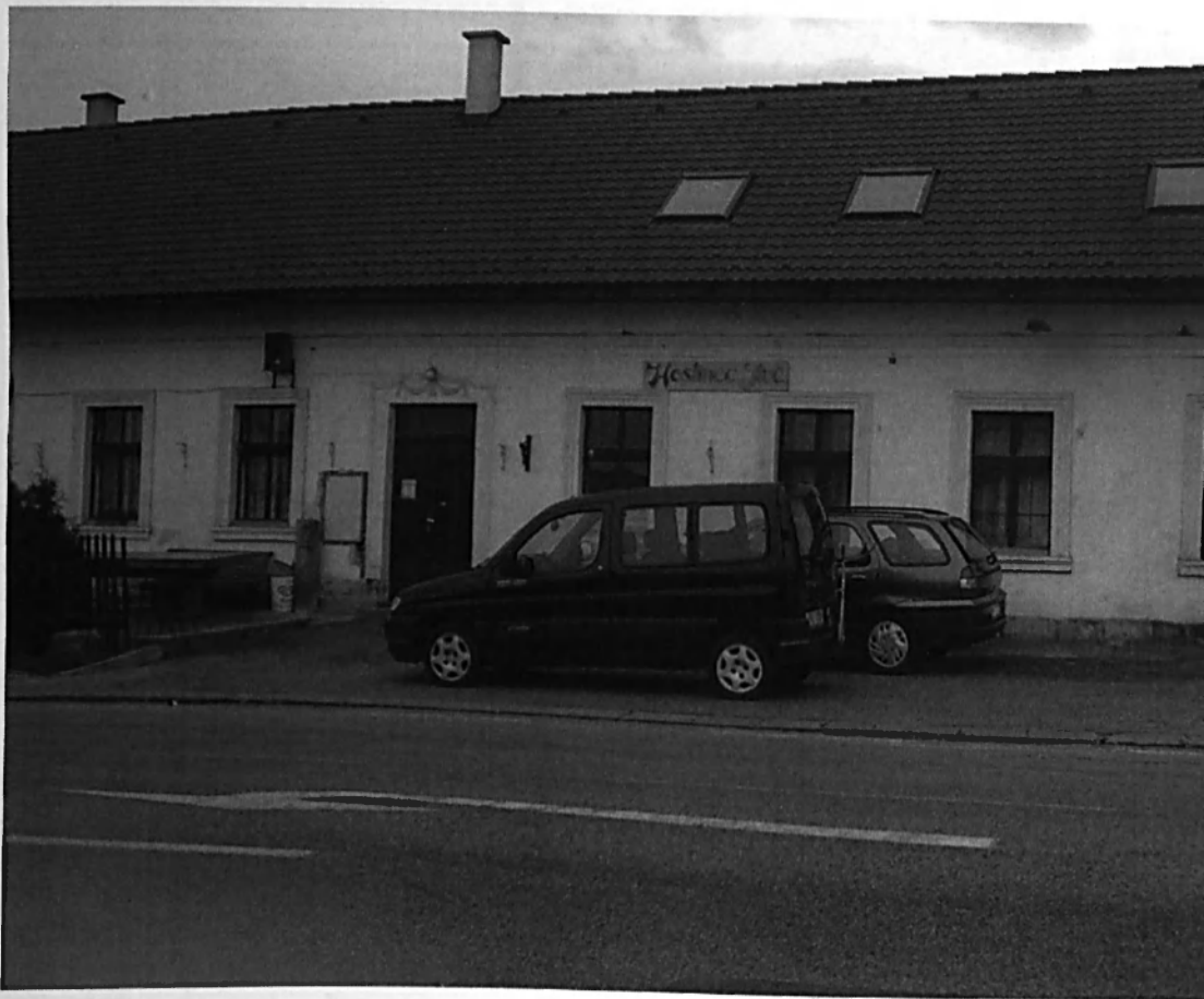
Obr. č. 4 Hospoda Na Jívě.
