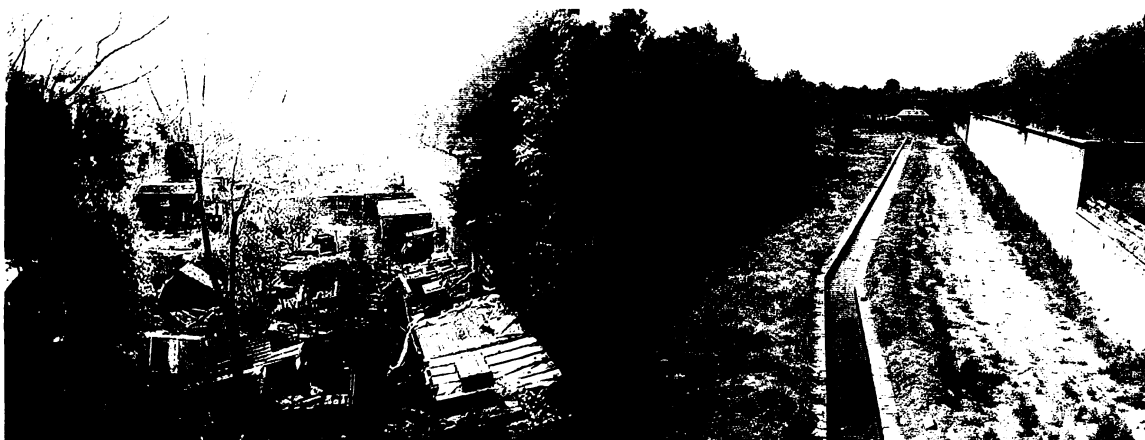
Obrázky č. II a č. III - Srovnání stavu vodních příkopů před a po vyčištění v roce 2003
