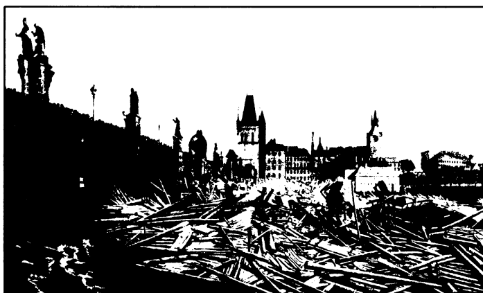
Obr. 4.2 Nakupení dřeva před Karlovým mostem v Praze při povodni v květnu 1872
