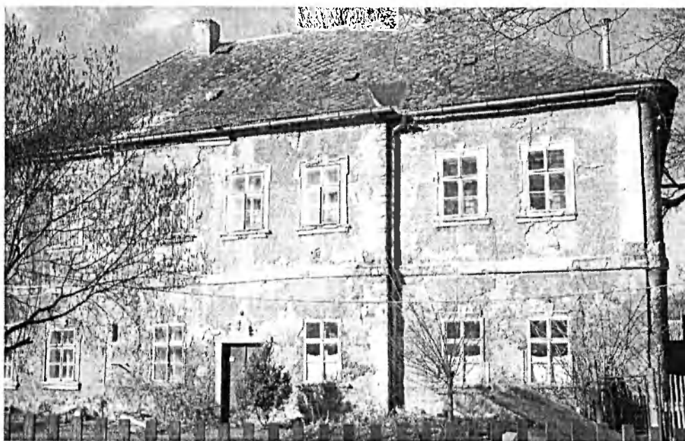
Fara v Bečově – současný stav
