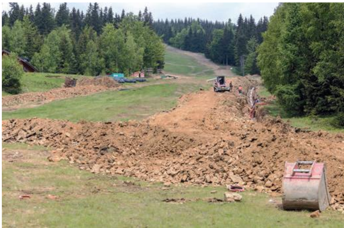
Obrázek 5: Rozvody technického zasněžování jsou ukládány po spádnicí, a přispívají tak k rychlejšímu odvádění vody z dotčené lokality (Medvědín, Špindlerův Mlýn), (foto Petr Flousek 27.5.2016).
