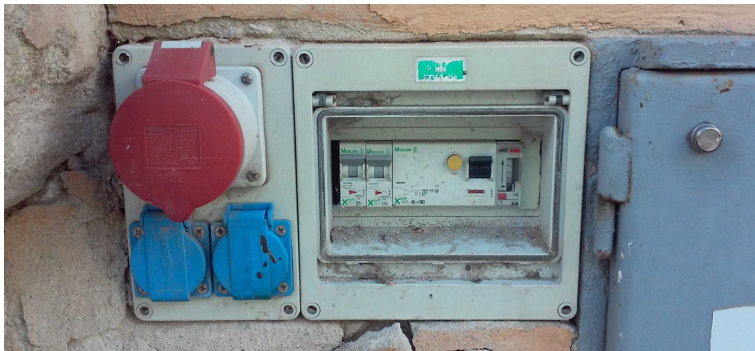
Obrázek 4.49: Venkovní rozvaděč s proudovým chráničem na jedné pražské tržnici
