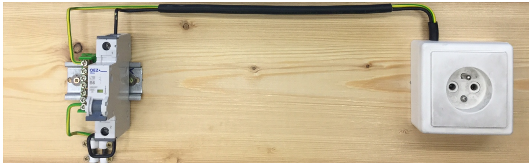
(a) Modul M1: Zapojení zásuvky je připraveno pro demonstraci sítě TN-C
