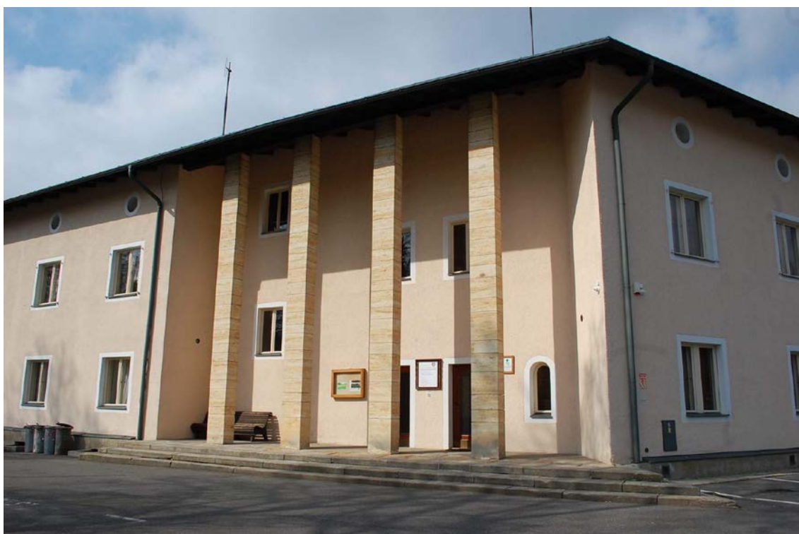
16. Budova Lesní správy v Lánech
