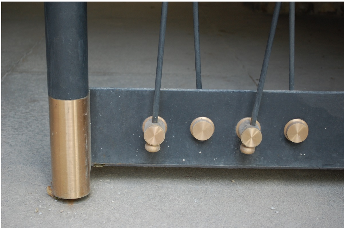
22. Detail mříže chránící vstup do dvora Tereziánského traktu
