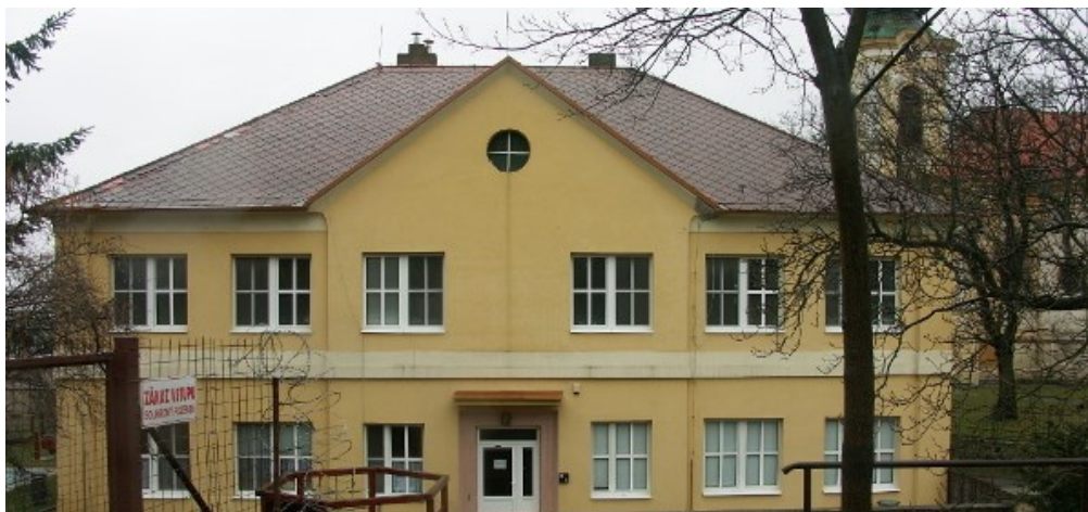
Mateřská škola, Odolena Voda. Původní budova základní školy. Foto autorka.
