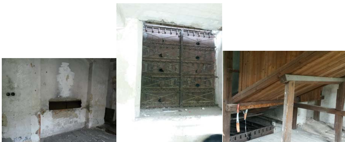
Obrázek 15: Zařizování typu "Ječmen" (zařizování umístěné do patrového „Hvozdu“)
