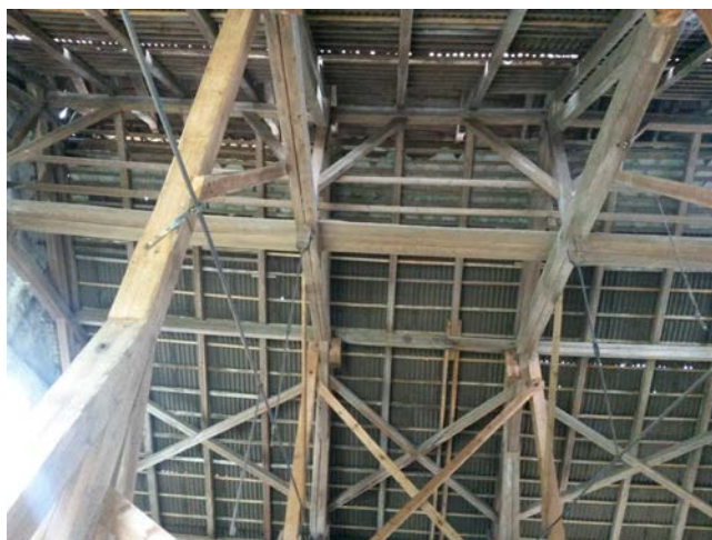
Obrázek 29: Provizorní oprava střechy po požáru
