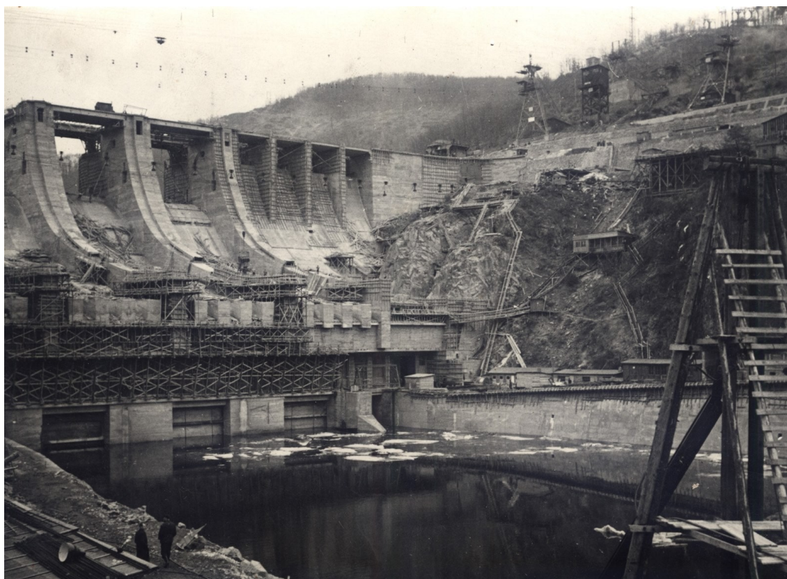
Obrázek č. 11: Stavba Slapské přehrady z 15. března 1954
