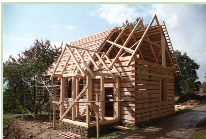
Obr. 15 Výstavba školy z Velkých Karlovic – Miloňova ve VMP 31. října 2007
