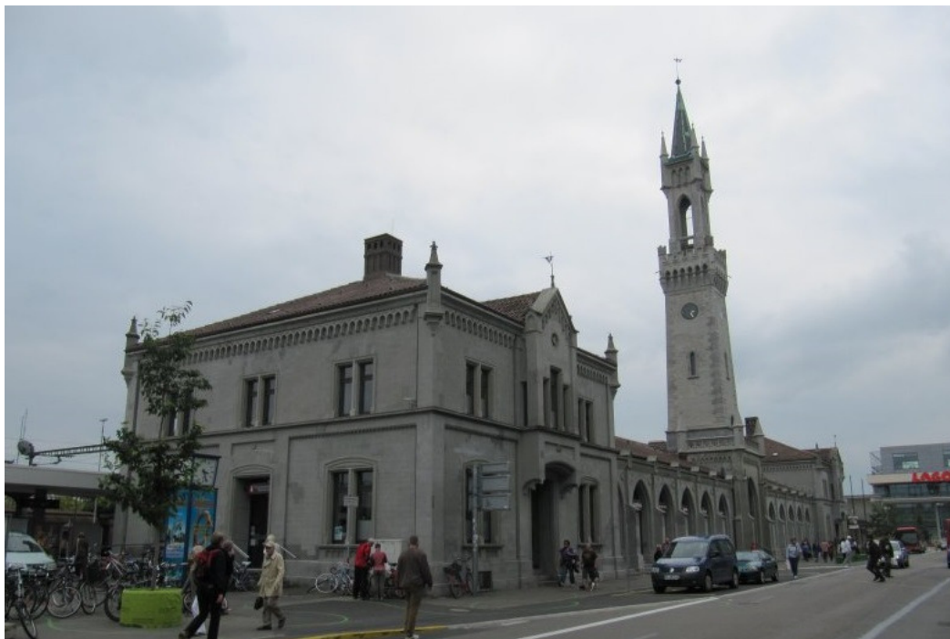
Celkový pohľad na železničnú stanicu (Bahnhofplatz). Ro výstavby: 1860-1863, autor: Heinrich Leonhart (1813-1878), neogotika.
