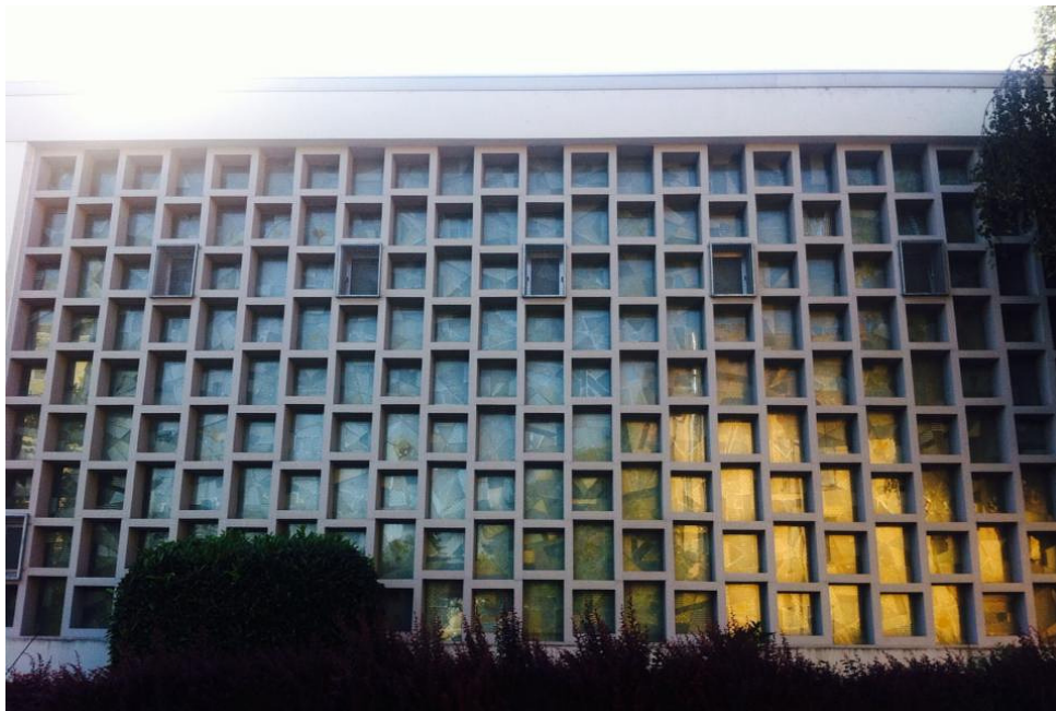
Stena kostola z východnej strany (Goethestrasse) zo sklobetónových kvádrov.
