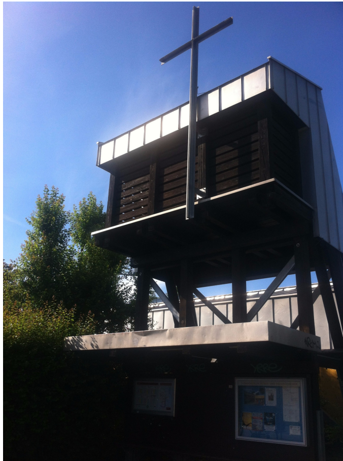
Zastávka autobusu priamo pod vežou kostola (južná strana, ul. Wollmatingerstrasse).
