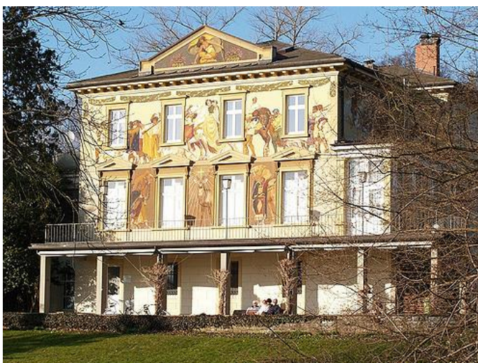
Obr. č. 18 Vila Prym , rok výstavby: 1860-1912, architekt: ???.
