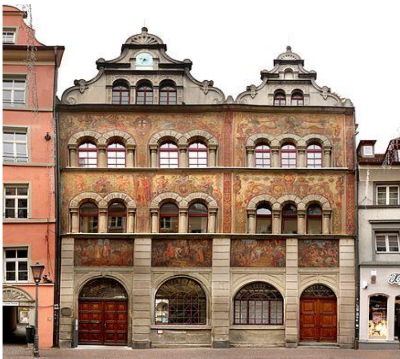
Obr. č. 89 K najdôležitejším verejným budovám mesta patrí stará radnica, kde sídli miestne zastupiteľstvo a občania sem prichádzajú riešiť svoje záujmy. V roku 1594 bola zriadená mestská kancelária, od roku 1848 ako radnica. Fasádu navrhol augsburgský maliar historizmu Ferdinand Wagner (1819-1881).
