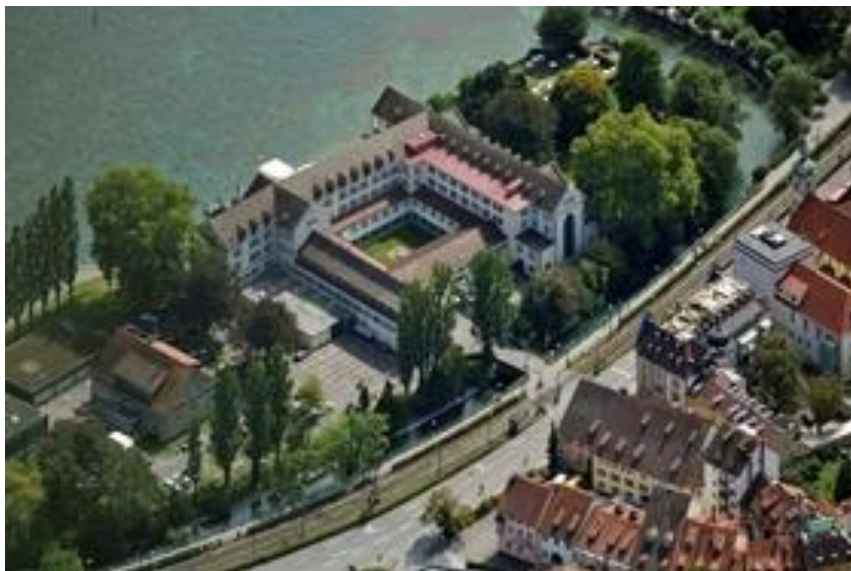
Obr. č. 2 Dominikánsky kláštor sv. Mikuláša (dnes hotel), založený biskupom Henrichom I., rok výstavby: 1236-1807.
