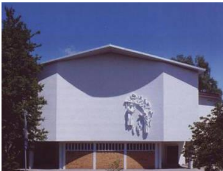
Obr. č. 21 Kostol sv. Mikuláša , rok výstavby: 1955-1956, architekt: ???.
