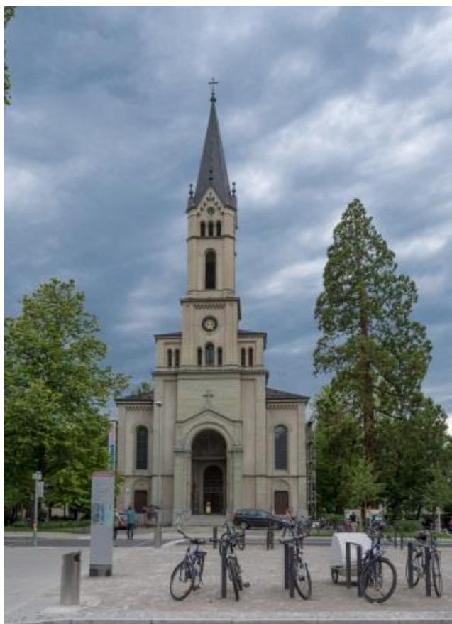
Obr. č. 10 Luteránsky kostol , rok výstavby: 1864-1873, architekt: H. Leonhart.
