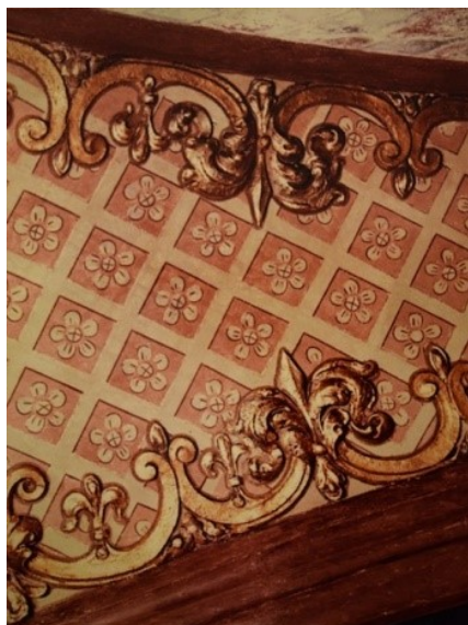
66. a Detail mezižební výmalby a štuků, klenba lodi, 1736
