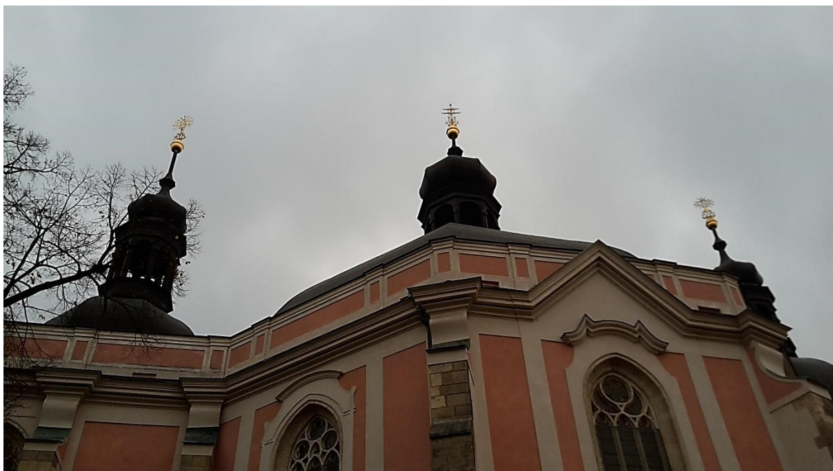
14. Barokizace fasády: parapet, konzoly, římsy, šambrány, 1713
