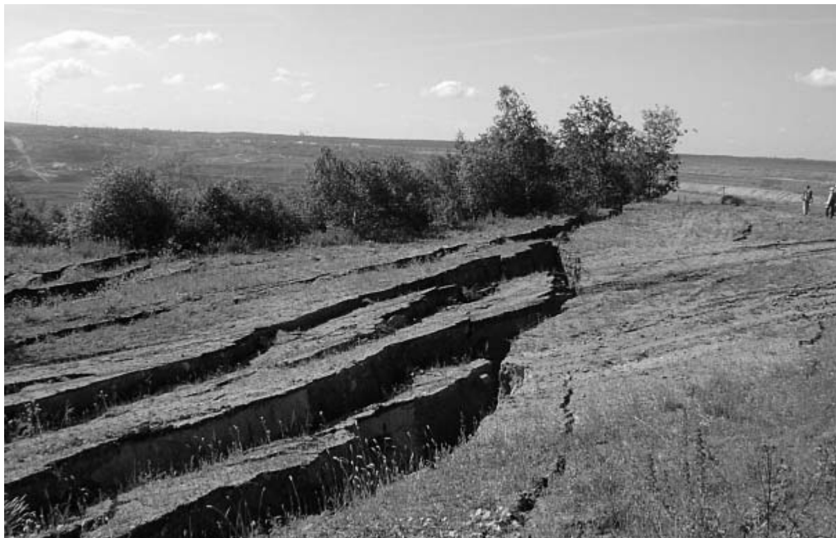
Příloha 5: Tahové trhliny v prostoru arboreta, způsobené sesuvem z června roku 2005 (Říha et al. 2005).
