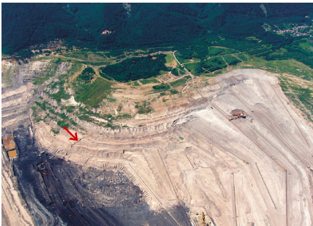
2-6. Těžba uhelné sloje při úpatí hor v blízkosti zámku Jezeří musí respektovat ochranný stabilizační pilř. V jeho centru spočívá zachovalé arboretum. Těžba skrývky postupuje směrem doprava k obci Černice. Uprostřed snímku je zřetelná průběžná strmá trhlina sesuvu z června 2005, která evidentně porušuje celé pánevní souvrství včetně uhelné sloje (Marek 2006).
