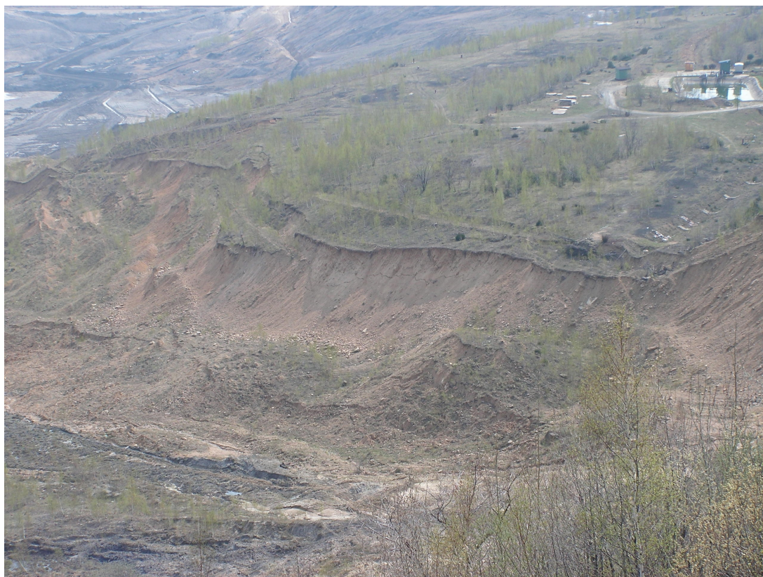
Příloha 56: Detailní pohled na sesuvné jevy v opěrném pilíři pod vrchem Jezeří (foto: autor).
