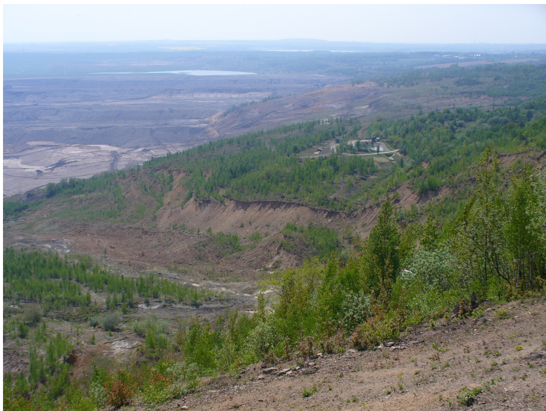
Příloha 55: Opěrný pilíř pod vrchem Jezeří, rotační sesuvy ve strmém antropogenním svahu (foto: autor).
