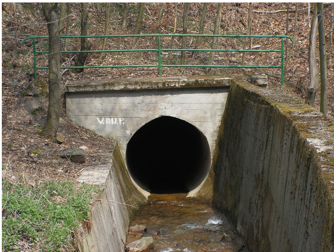
Příloha 54: Vstupní portál přeložky Šramnického potoka (foto: autor).
