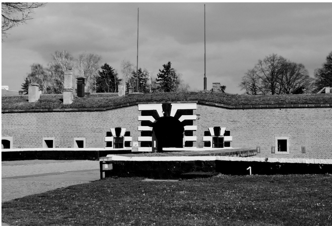
15. Terezín, Malá pevnost, pohled na vstupní bránu, stav k roku 2016.
