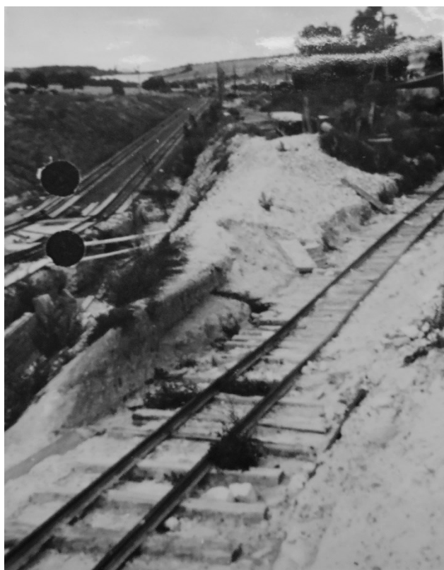
33. Litoměřice , opuštěné staveniště v okolí továrny Richard, 1945.
