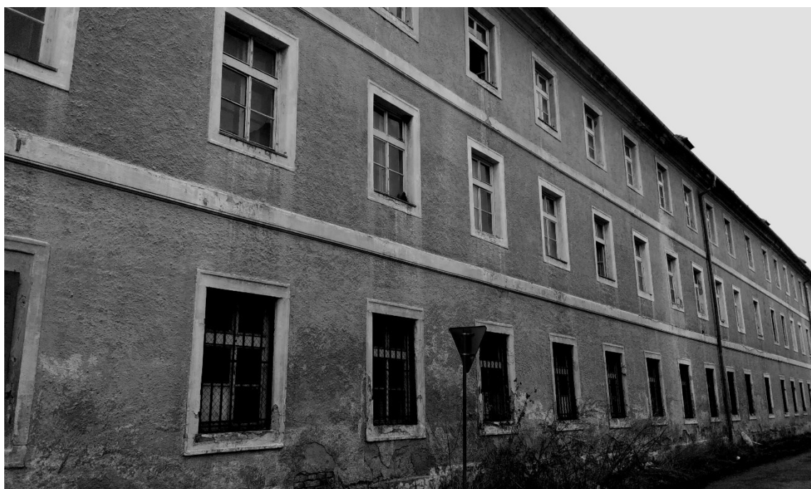
17. Terezín , Drážďanské kasárny, ubikace žen v době fungování ghetta 1941-1945, stav k roku 2017.
