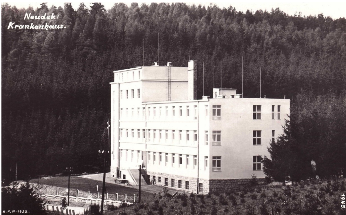
33) Nejdecká okresní všeobecná nemocnice byla dokončena na podzim 1932
