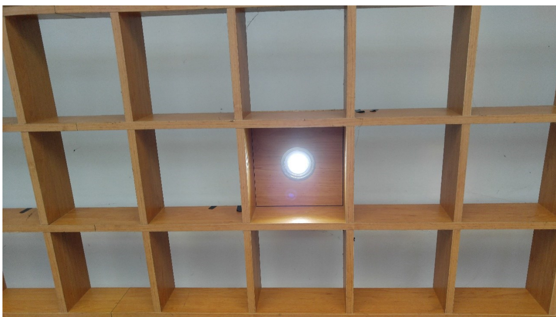
Příloha č. 19: Bílé zářivky zavěšené na konstrukci (obrázek)
