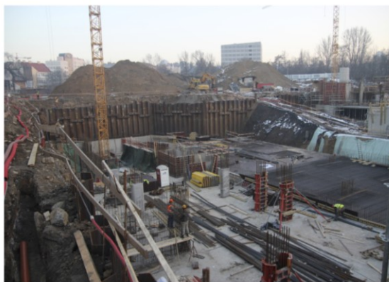
Obr. č. 37: Projekty Palmovka Open Park 3 a 4 v průběhu realizace Zdroj: Rathová 2017
