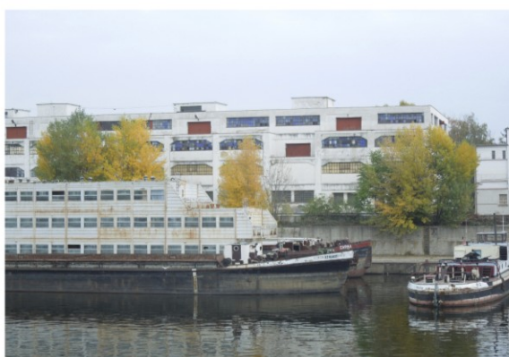
Obr. č. 16: Plavidla a památkově chráněná budova překladiště na přístavní koše ve funkcionalistickém stylu Zdroj: Rathová 2016
