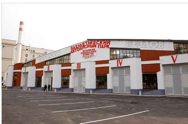
Obr. 45: Bývalá budova muzea Garage.
