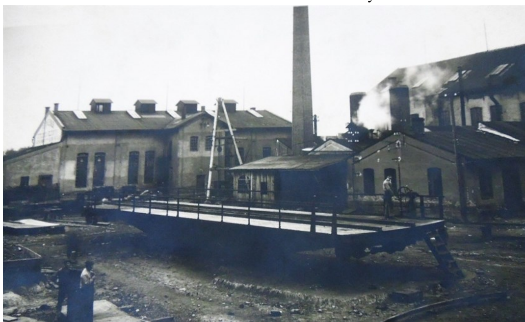
Příloha 4: Pohled do dvora továrny
