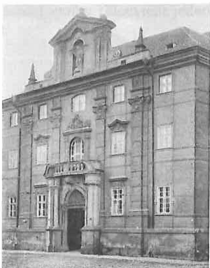
Staré budovy universitní v Klementinu.
