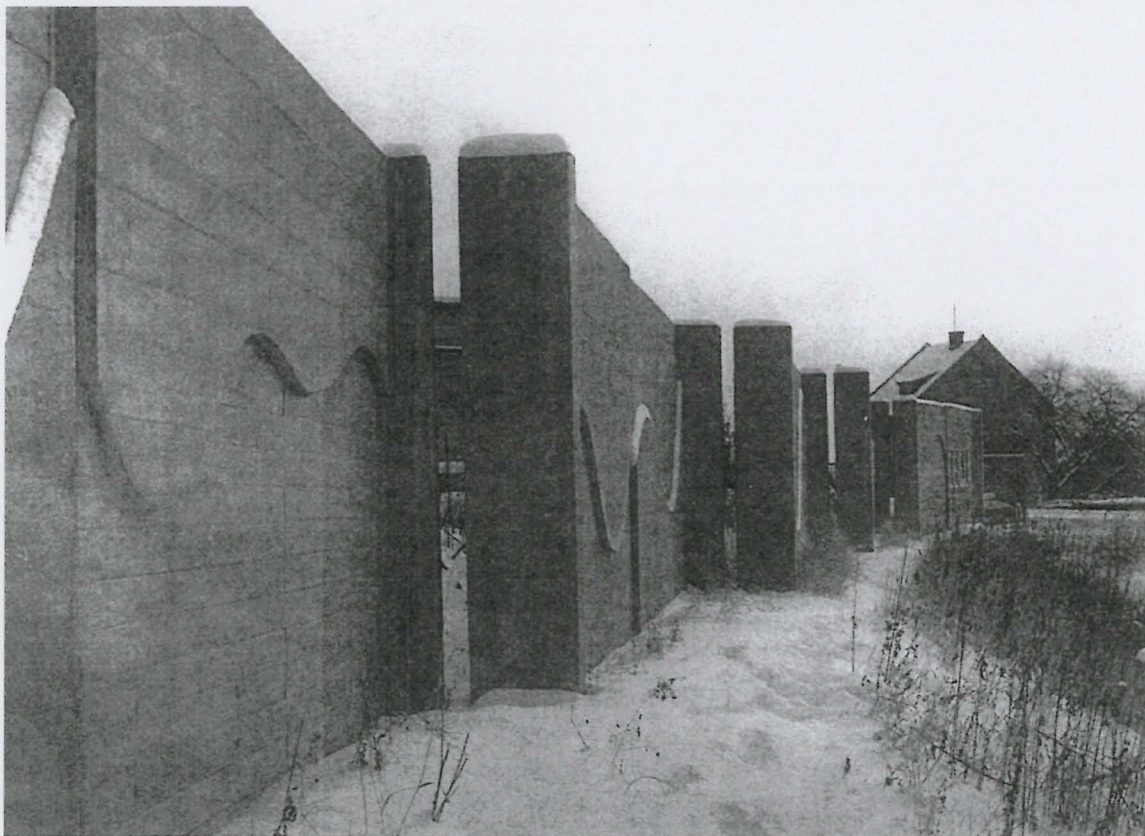
128 Reliéfni stěna u budovy Tělovýchovné jednoty Tesla, Brno-Lesná, 1982 beton, v. 2,8 m, š. cca 25 m
