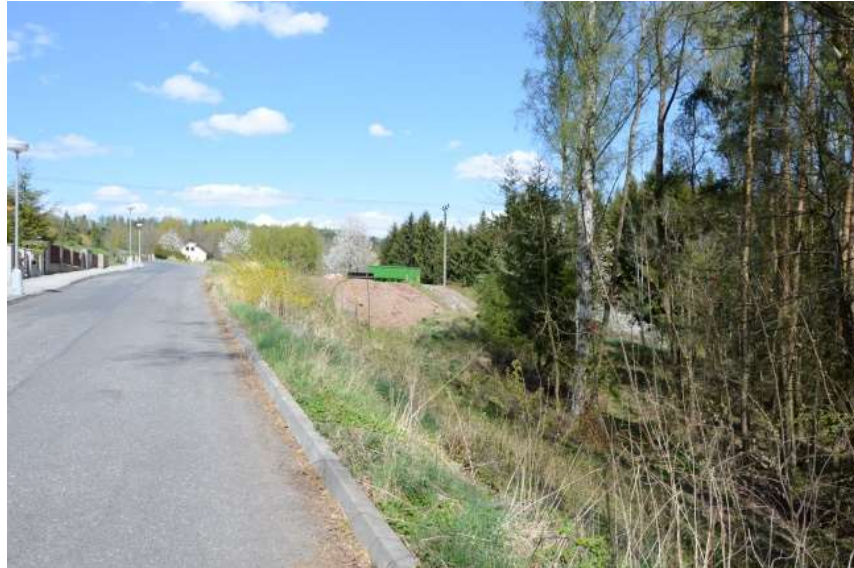
DB13a – Navážky (nad zalesněnou částí svahu)
