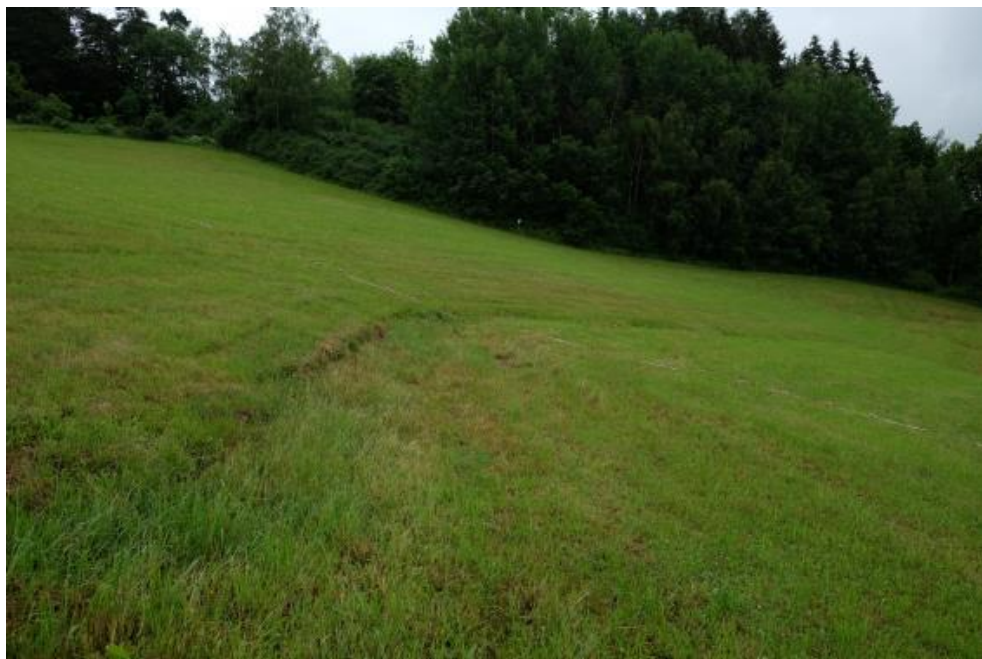
Obr. 23: Trhlina vedoucí svahem v SV části svahu „U Čtrnácti pomocníků“ (vlastní dokumentace)
