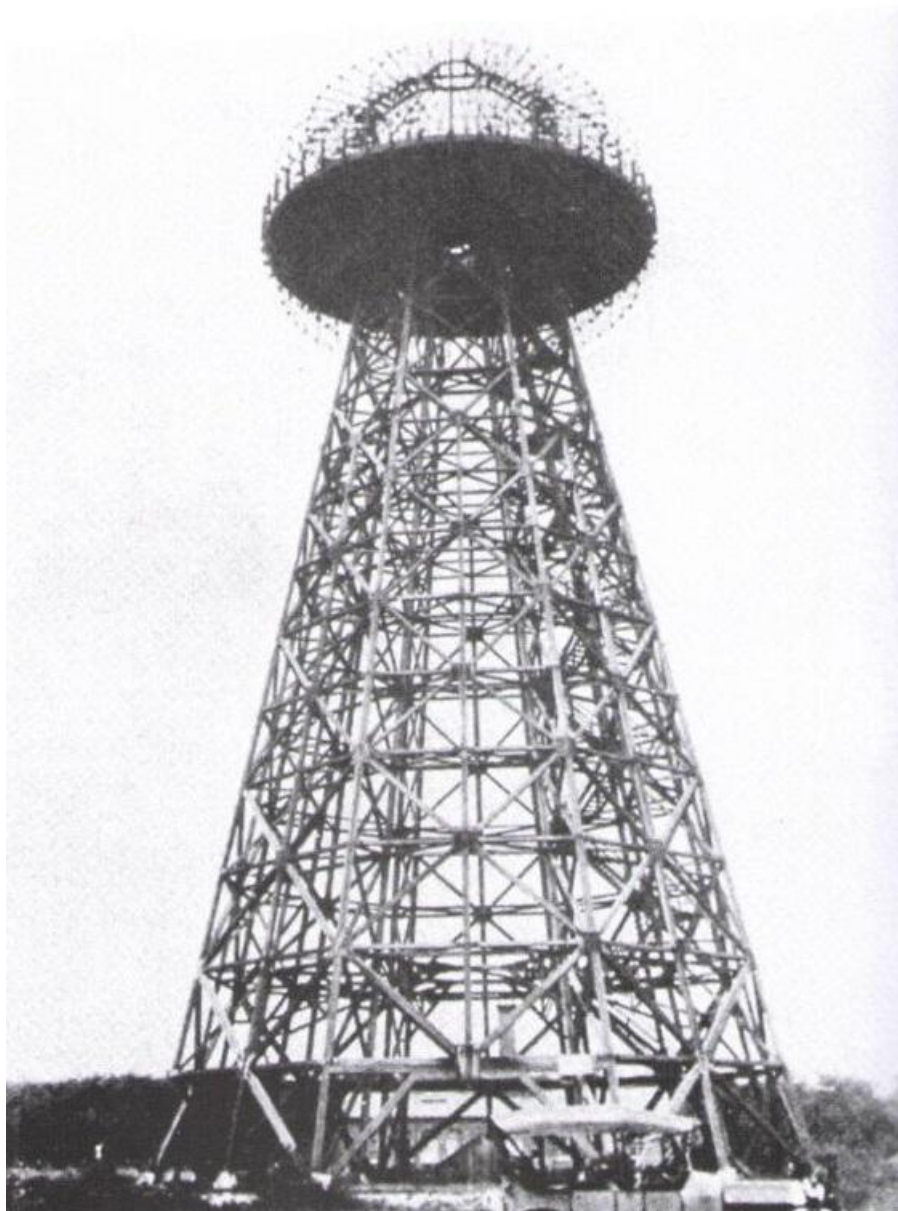
Nedostavěná věž Světového telegrafního centra Wardencliffu na Long Islandu
