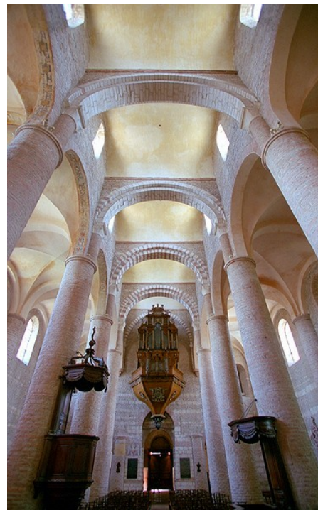
40. Tournus , Sv. Philibert, pohled na zaklenutí vedlejší lodi a na zaklenutí hlavní lodi
