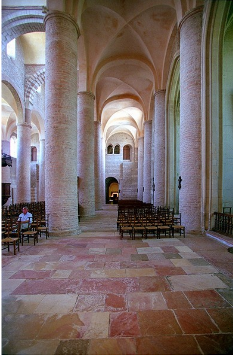
40. Tournus , Sv. Philibert, pohled na zaklenutí vedlejší lodi a na zaklenutí hlavní lodi
