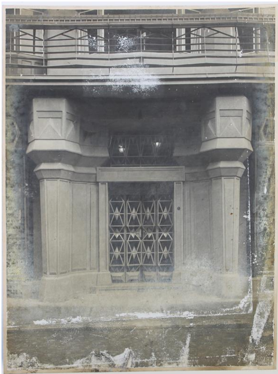
70. Josef Gočár: dům U černé Matky Boží v Celetné ulici v Praze, 1911–1912, detail vstupu krytého mříží a lemovaného sloupy
