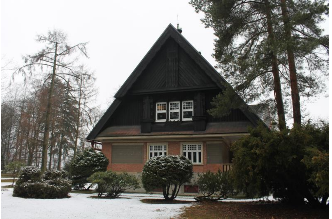
17. Josef Gočár: Červená vila v Kruceburku, 1907–1909, pohled na jihovýchodní průčelí
