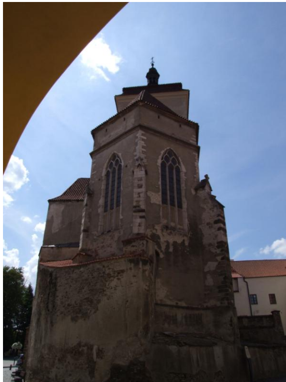
48. Strakonice , kostel sv. Prokopa, presbytář, konec 13. stol., pohled od východu
