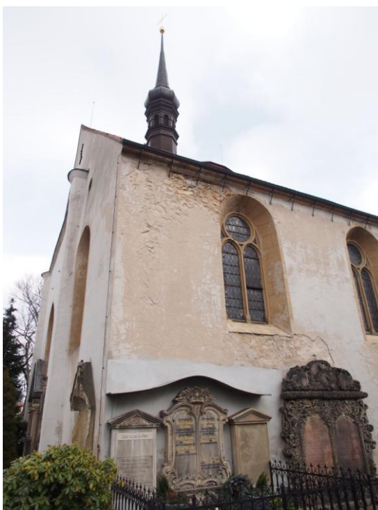
6. Žitava , kostel Panny Marie, konec 13. století, pohled jihozápadu
