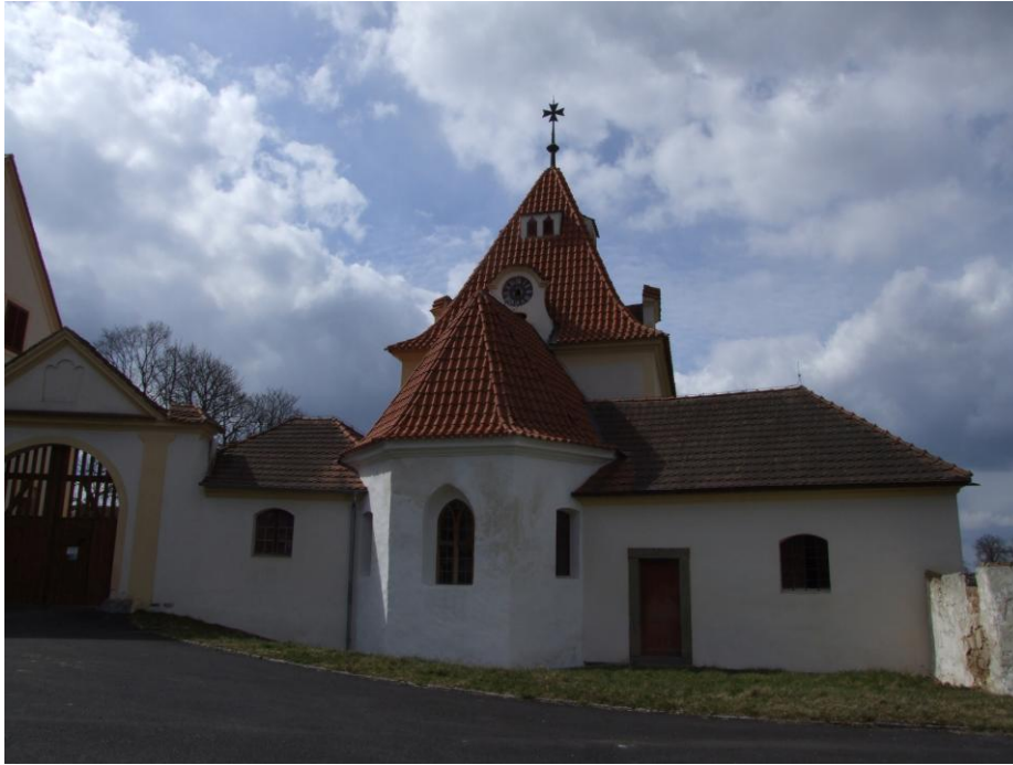
11. Varvažov , kaple sv. Kateřiny, konec 13. století, pohled od východu
