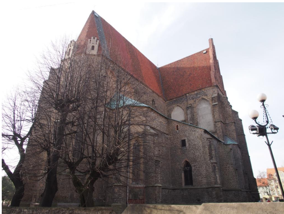
5. Stříhom , kostel sv. Petra a Pavla, cca 1330 – cca 1500, pohled od severovýchodu
