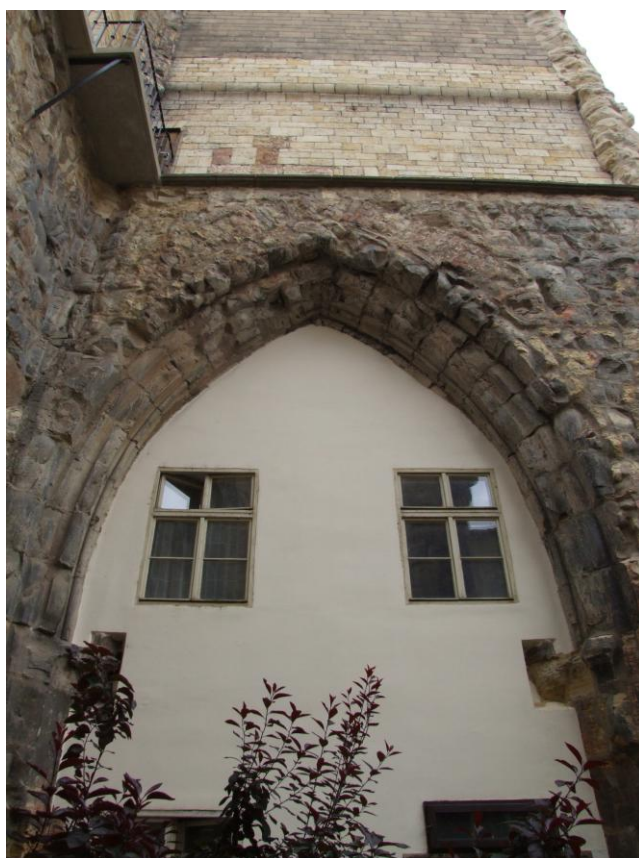
62. Praha , kostel Panny Marie pod řetězem, arkáda v podvěží severní věže, kol. 1390, pohled od jihu
