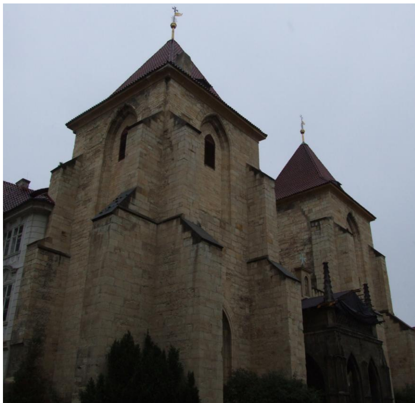
1. Praha , kostel Panny Marie pod řetězem, po 1169, pohled od severozápadu
