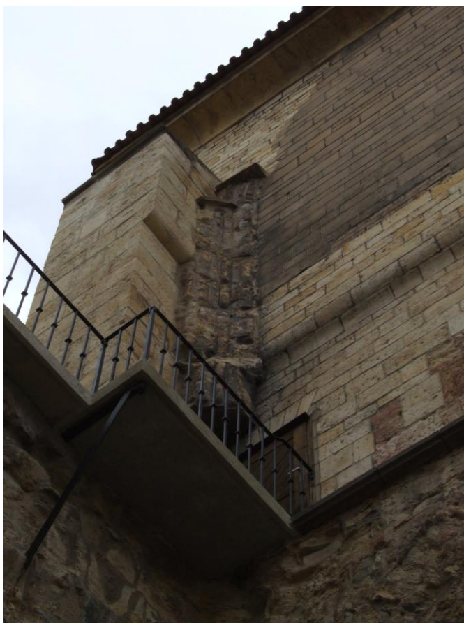
59. Praha , kostel Panny Marie pod řetězem, přípory v rozích vymezených věžemi a zříceninou stěny západního průčelí, kol. 1390
