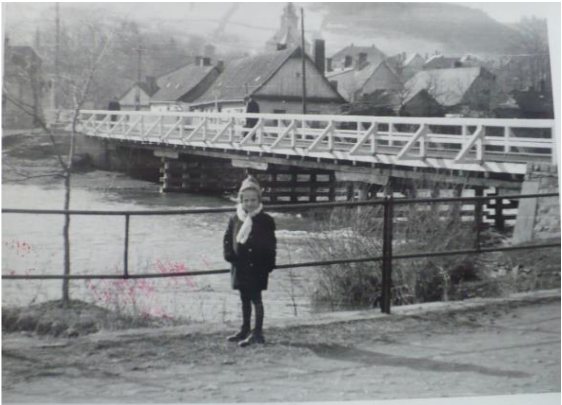
Obrázek 6: Zemský archiv v Opavě - SOkA Nový Jičín, Sbíрка fotografického materiálu Odry, Nově postavený dřevěný most (starý byl zničen v bojích) 1945, II.
