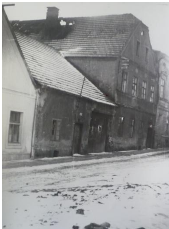
Obrázek 19: Zemský archiv v Opavě - SOkA Nový Jičín, Sběrka fotografického materiálu Odry, Demolice na Radniční ulici 1950, II.
