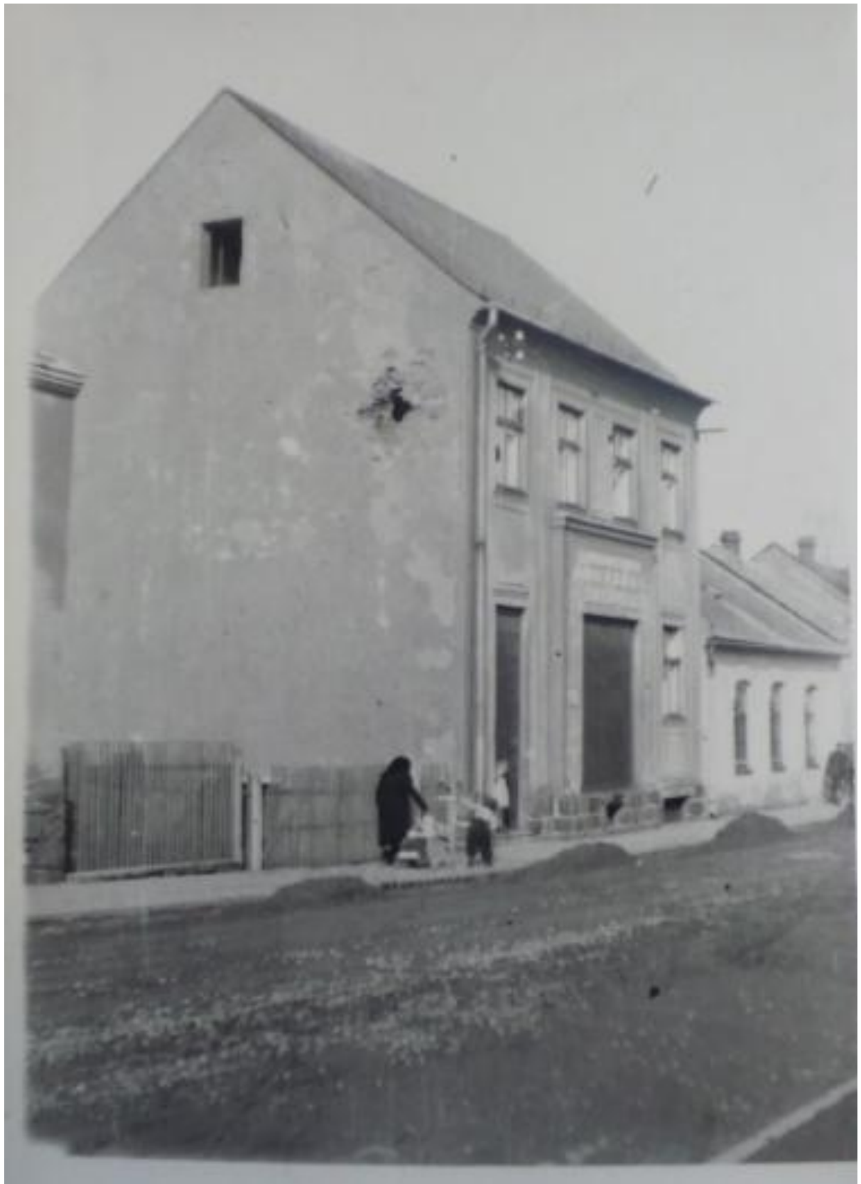
Obrázek 4: Zemský archiv v Opavě - SOkA Nový Jičín, Sběrka fotografického materiálu Odry, Bývalá filiálka konzumního obchodu, na domě díra po granátu, granát proletěl celým domem na druhou stranu 1945
