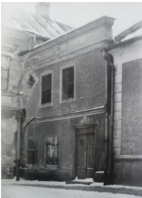
Obrázek 18: Zemský archiv v Opavě - SOkA Nový Jičín, Sběrka fotografického materiálu Odry, Demolice na Radniční ulici 1950, I.
