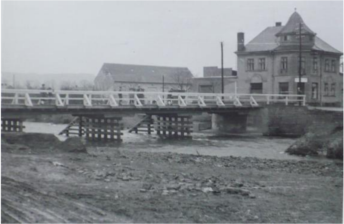
Obrázek 5: Zemský archiv v Opavě - SOkA Nový Jičín, Sbíрка fotografického materiálu Odry, Nově postavený dřevěný most (starý byl zničen v bojích) 1945, I.
