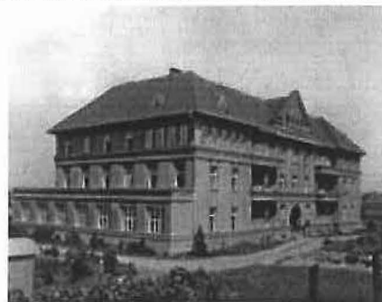
budova Jedličkova ústavu v době vzniku
