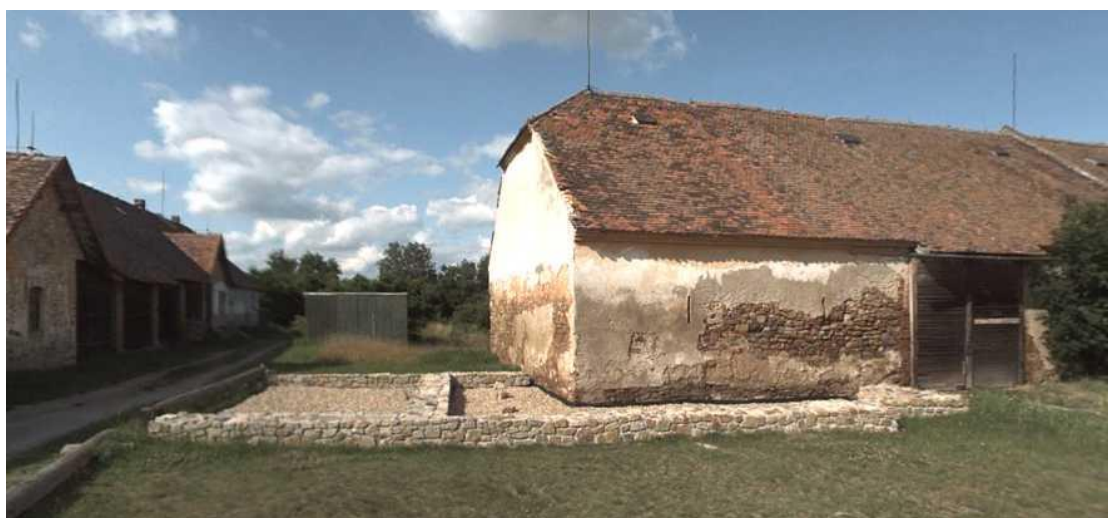
Obr. 5: Současný stav Kostela I. 14
