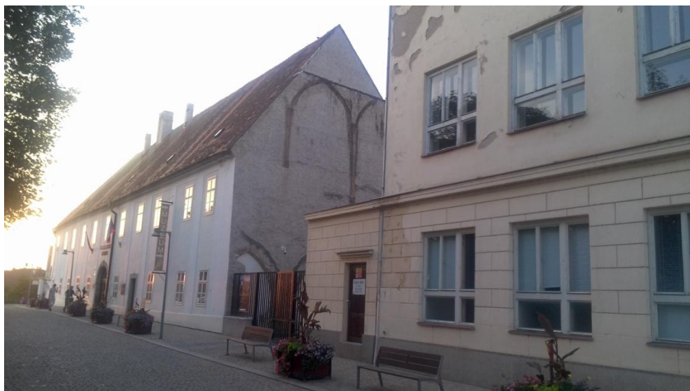
Obr. 8: Pohled na proluku vzniklou zbořením kostela s bývalou oratoří, mezi mužským a ženským klášterem 80
