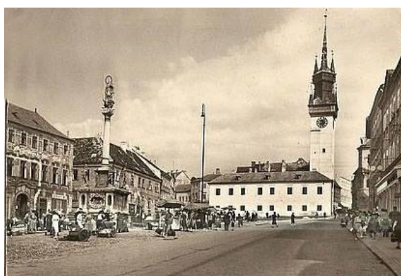
Obr. 28: Pohled na vzniklý parčík po vybombardovaném obytném „špalíčku“ 100
