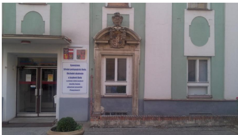
Obr. 9: Původní barokní portál dormitáře klarisek, vedle současného nově proraženého vchodu do školy 81
