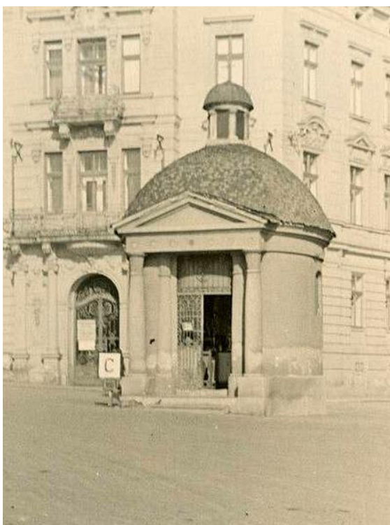
Obr. 48: Detail Mariánské kaple 140
