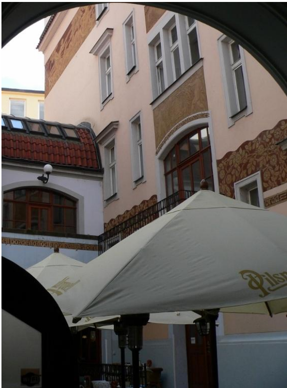
[37] Josef Fanta: Dům U Vejvodů, 1909, pohled do dvora, Jilská 353, Praha
