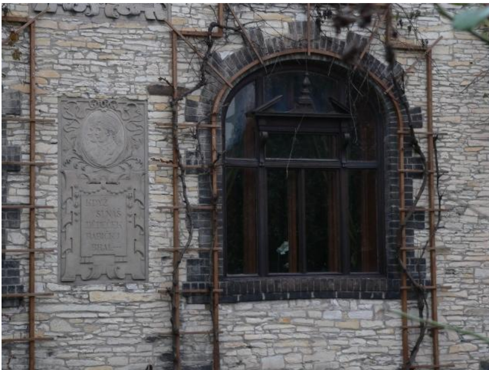
[4] Josef Fanta: Obereignerova vila, 1897, detail okna, Havlíčkova 1, Poděbrady
