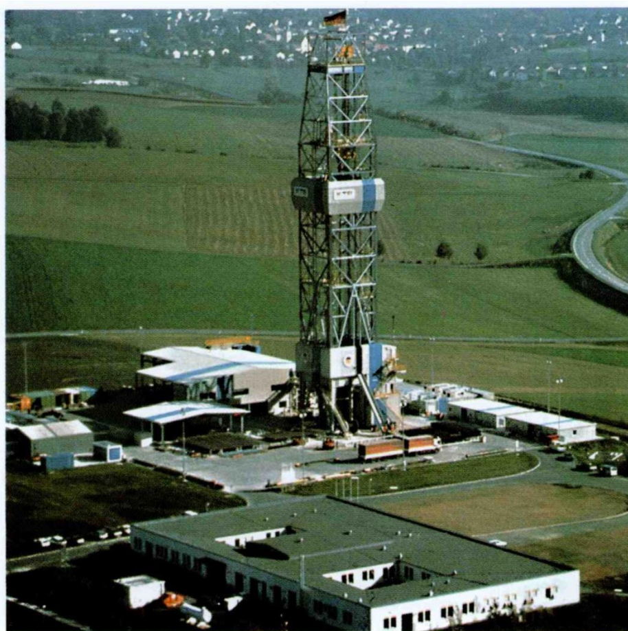
Obr. 5.2: Vrtná věž vrtu KTB, jednoho z velmi významných průzkumných vrtů na světě, jež pomohl pochopit i stavbu Českého Masivu.
