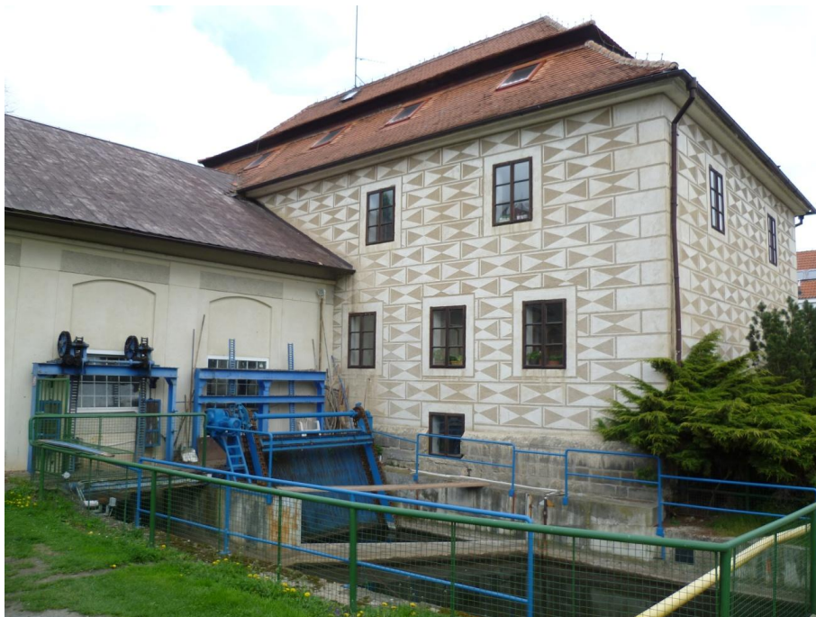
Obrázek 3.5: Archiv ČHMÚ a náhon s malou vodní elektrárnou v Brozanech nad Ohří
