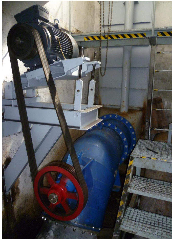
Obrázek 3.6: Turbína a generátor MVE Brozany
