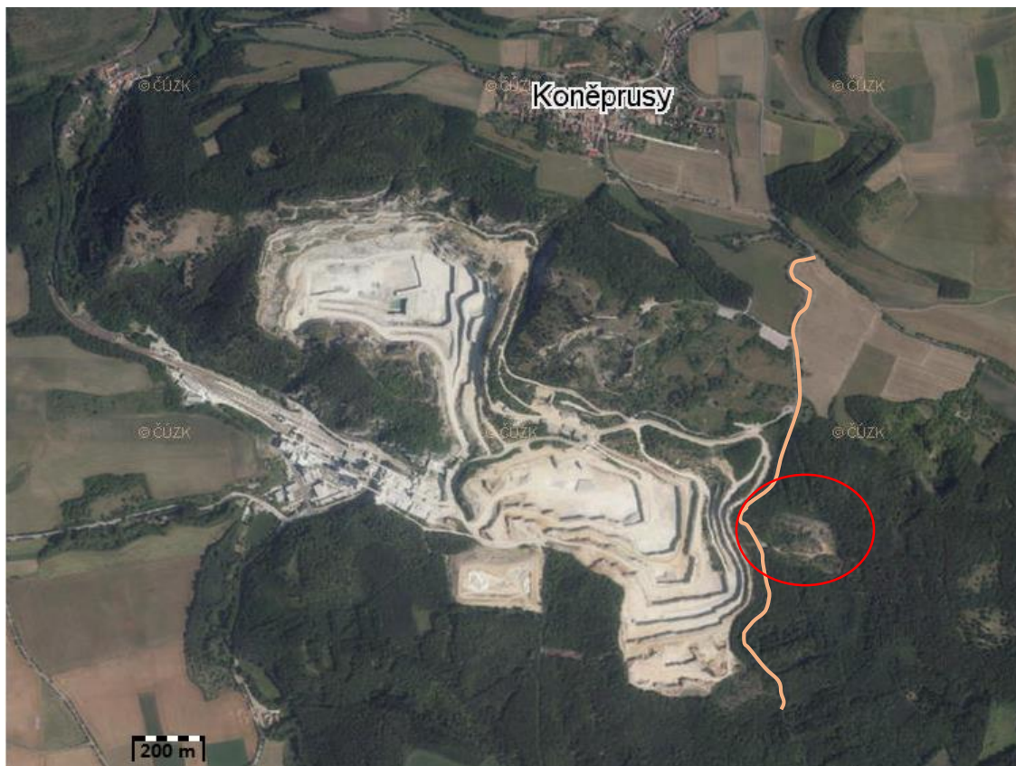
Obr. 6: Aktuální letecký snímek lomu Čertovy schody u Koněprus, s vyznačenou částí komunikace a již opuštěným lomem, který postupně zarůstá vegetací (zdroj: http://geoportal.cuzk.cz/geoprohlizec/ )
