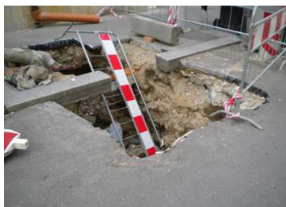
Obrázek 11: Správně označené prosklené dveře Obrázek 12: Nebezpečný výkop
