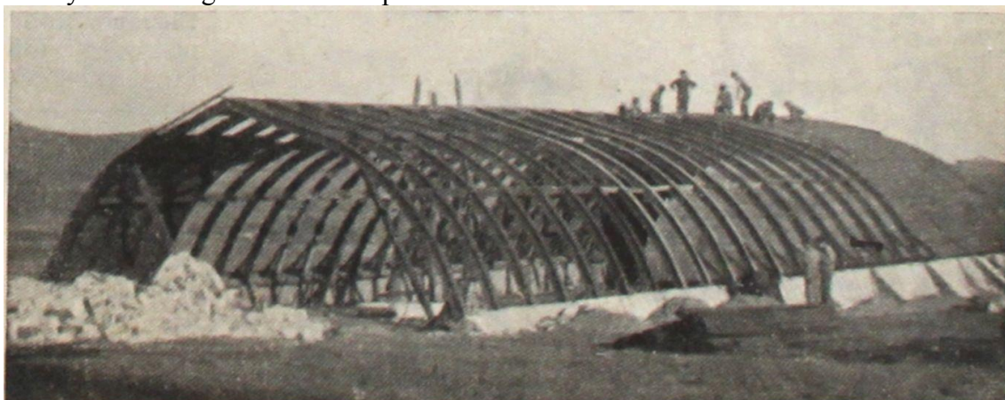
15. Výstavba hangáru v České Lípě
