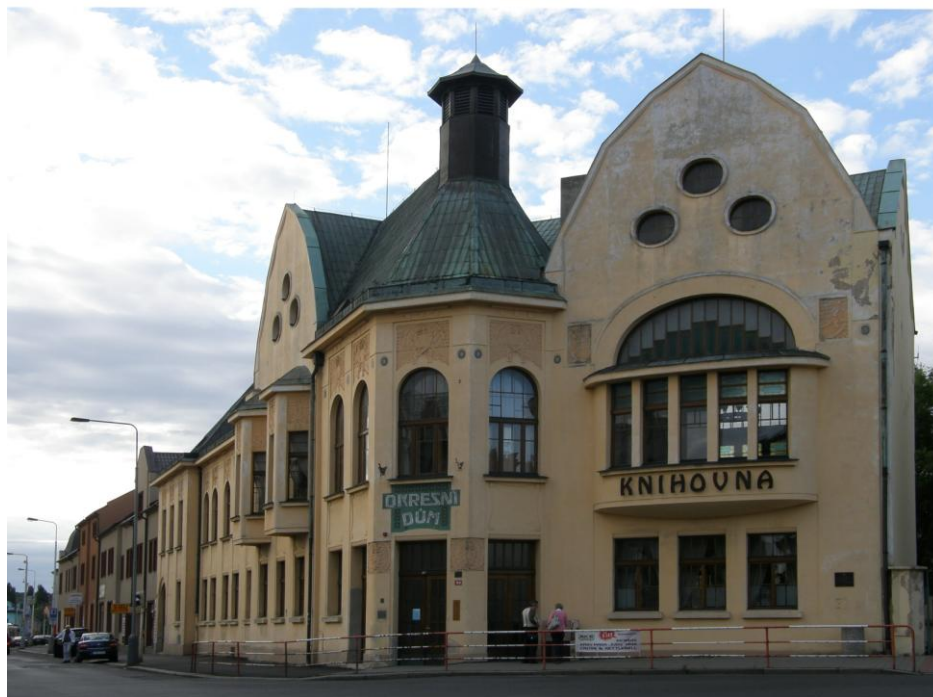
Obrázek 1 Hlavní budova SVK v Kladně
