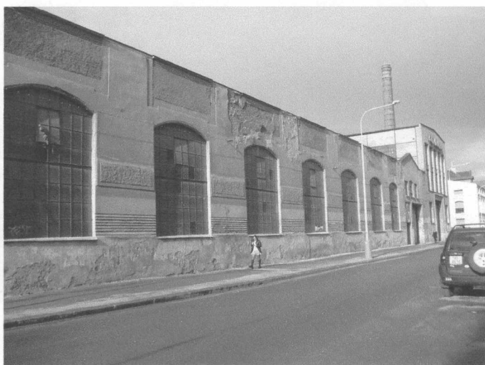
bývalá kotlářna (Pernerova ulice)
