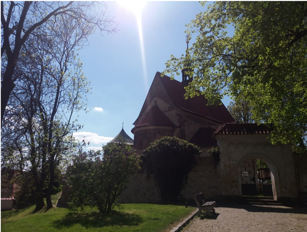
1. Kostel Stětí sv. Jana Křtitele, Praha-Dolní Chabry, pohled od severovýchodu
