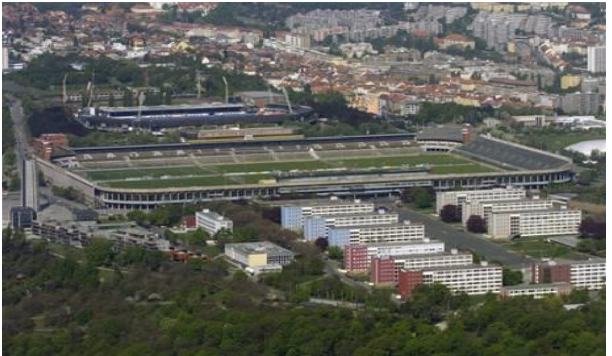
Obr. č. 10: Strahovský stadion – současný stav
