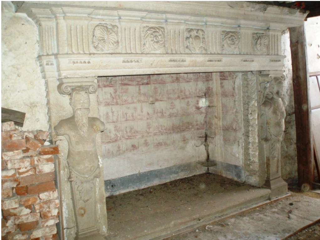
51. Kaceřov, krb ve velkém sále, první patro východního křídla
