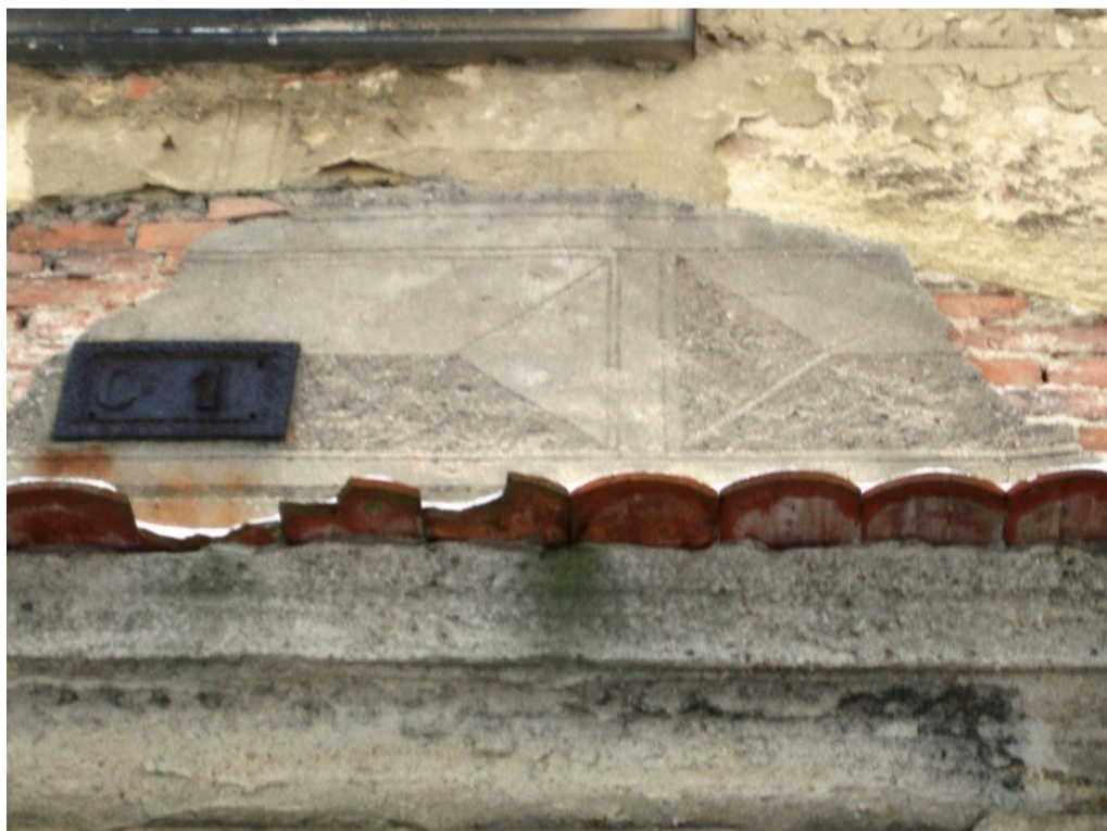
61. Kaceřov, fragment sgrafitové výzdoby na východním průčelí
