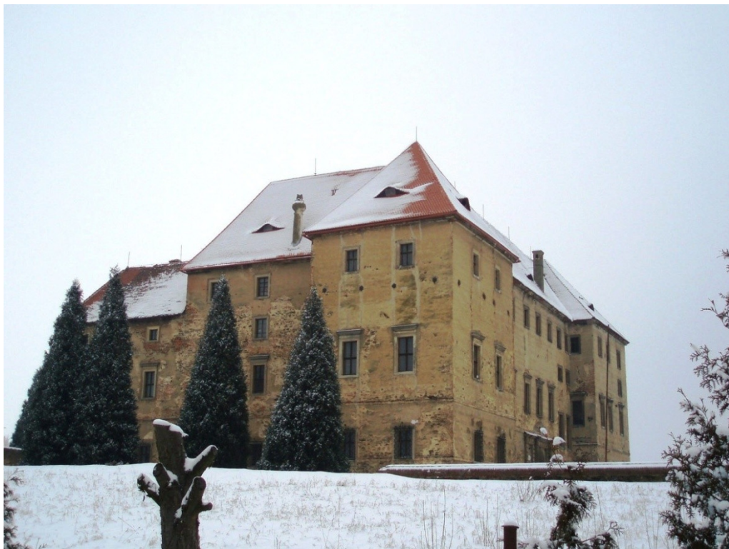
33. Kaceřov, jižní fasáda s komínem ve tvaru tulipánu
