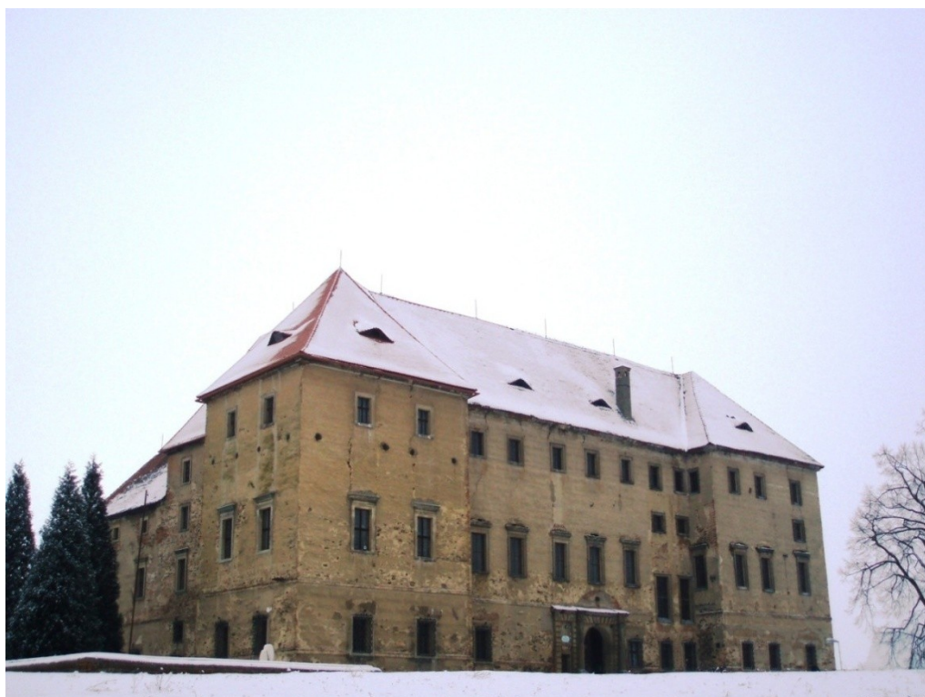
37. Kaceřov, hlavní průčelí, pohled od východu
