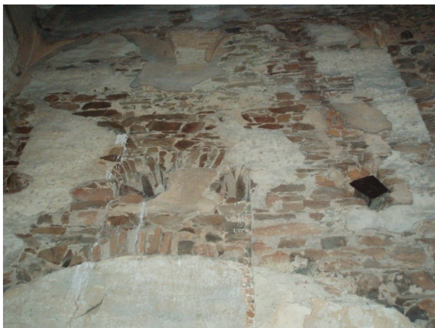
20. Kaceřov, detail zdiva v interiéru
