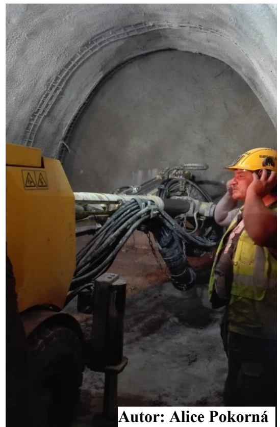
Obr. 5 Důlní stroj Boomer T1D navrtávající čelbu tunelu
