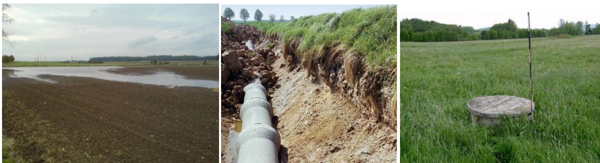
Obrázek 4: zamokřené pole (vlevo); trubková drenáž (uprostřed) a drenážní šachta (vpravo) (Vopravil a kol., 2010)
