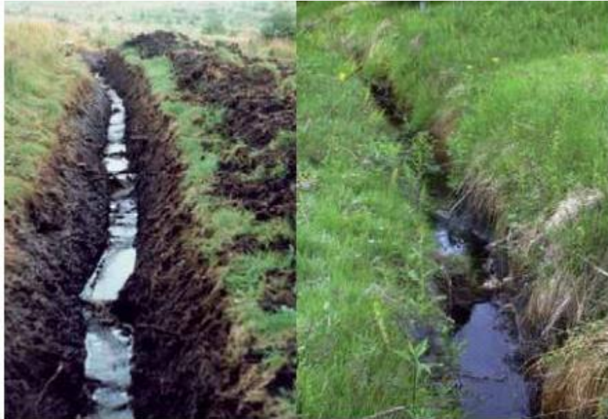
Obrázek 6: srovnání nově vybudovaného kanálu se stavem po 6 letech (Orlické hory) (Černohous a kol., 2012)
