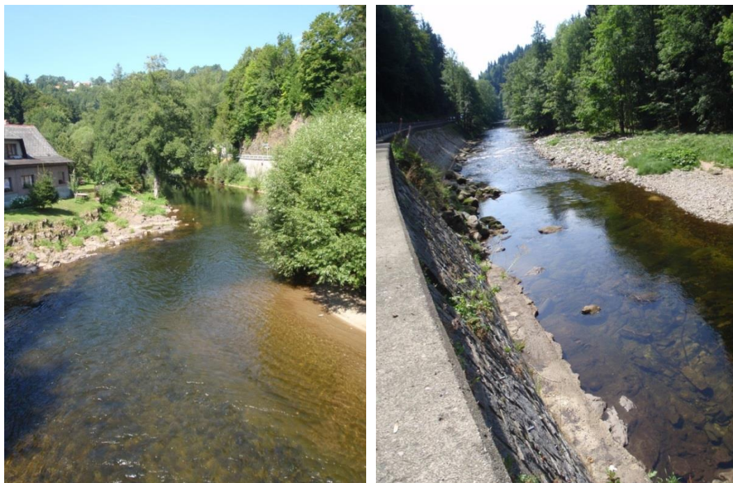
Obr. 49: Roztroušená zástavba v příbřežní zóně v úseku JIZ023 (vlevo) a opevnění břehu betonem a kamennou dlažbou v úseku JIZ055 (vpravo)
