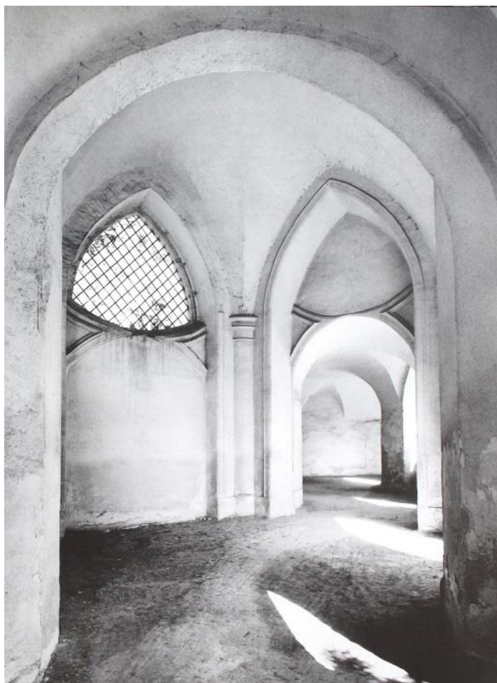
4 Vnitřní průhled ambitem
