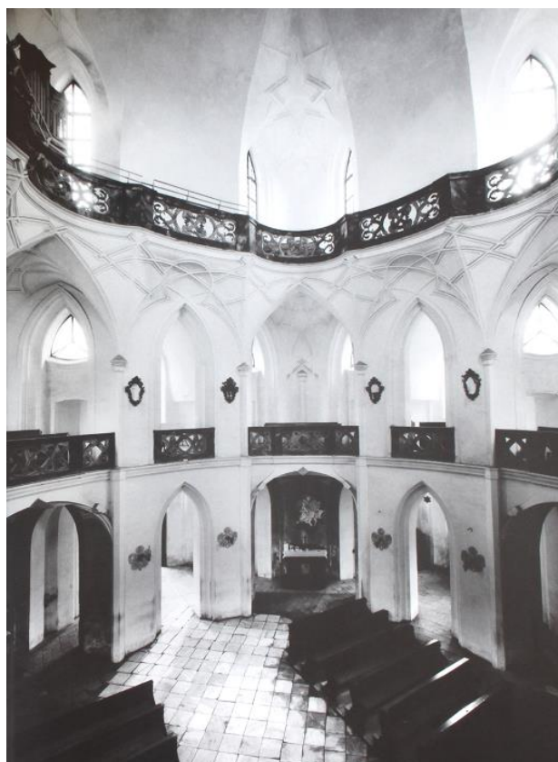
10 Interiér - průhled prostorem lodi v úrovni první empory
